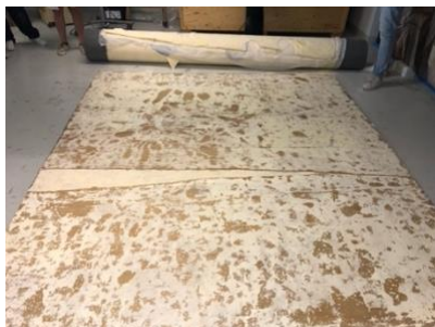
Figura 20. Obra tras fase de arranque.
