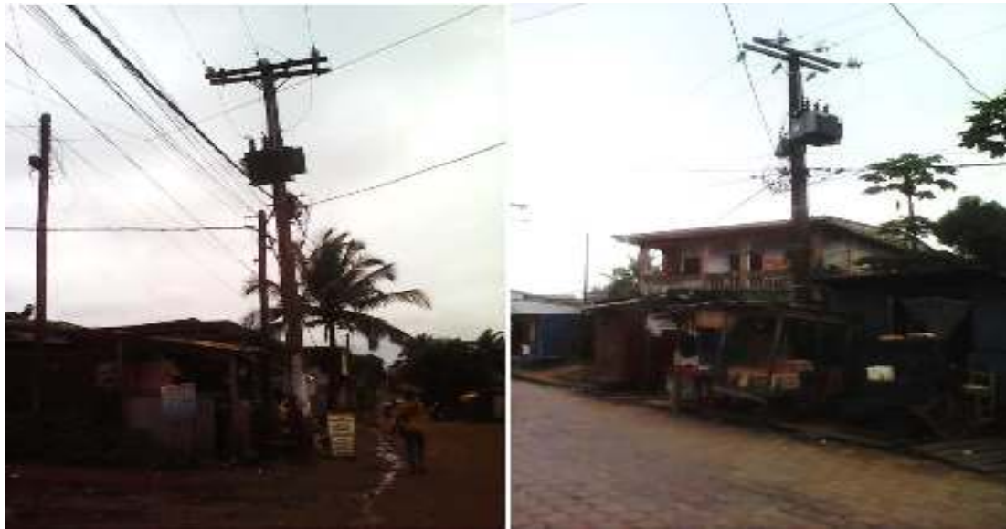
Figure 60: Cohabitation entre les populations et réseau électrique en milieu urbain Source : Moukengué, 2015.
