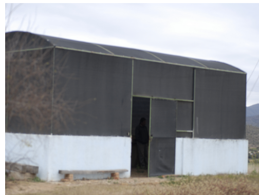
Figura 39: Invernadero, Centro de Conservación, Pulquina
