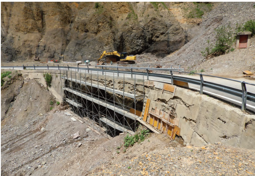
Figure 7a - Renovation works of a bridge (Lumiei Valley) / Lavori di ristrutturazione di un ponte (Val Lumiei) (Photo G. Rassati)
