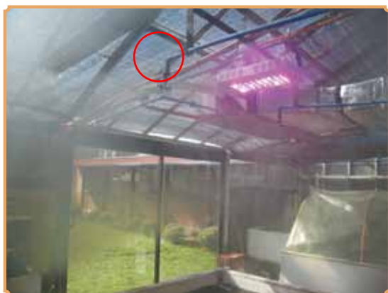
Foto 5. Sistema de nebulización automática bajo invernadero y micro-túneles.
