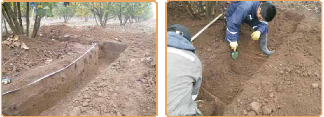
Foto 7. Construcción de calicata para determinación práctica de permeabilidad del suelo, comuna de Nueva Imperial, Región de La Araucanía, Chile.
