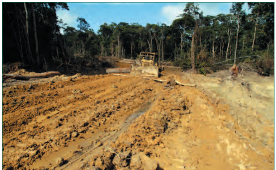
Figure 5.6. Une route en construction.
