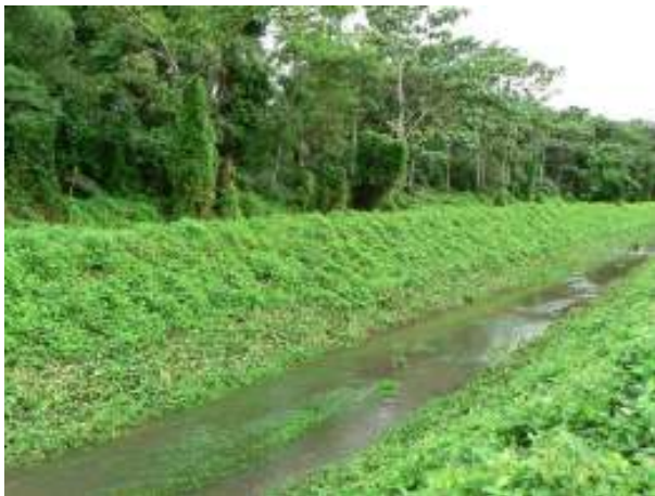
Canal Perimetral y taludes con kudzú y Centrosema , frente a Planta Gas.
