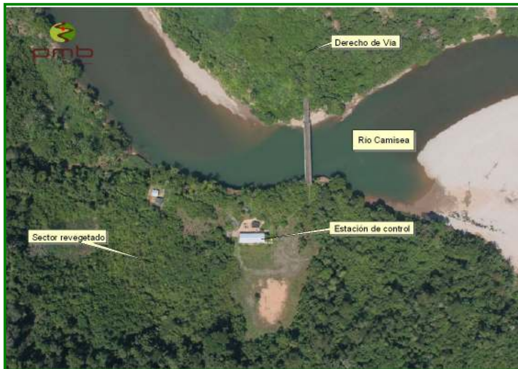
Figura 12. Fotografía Aérea Flowline Malvinas-San Martín 3 (Kp10). Cruce del río Camisea y estación de control.
