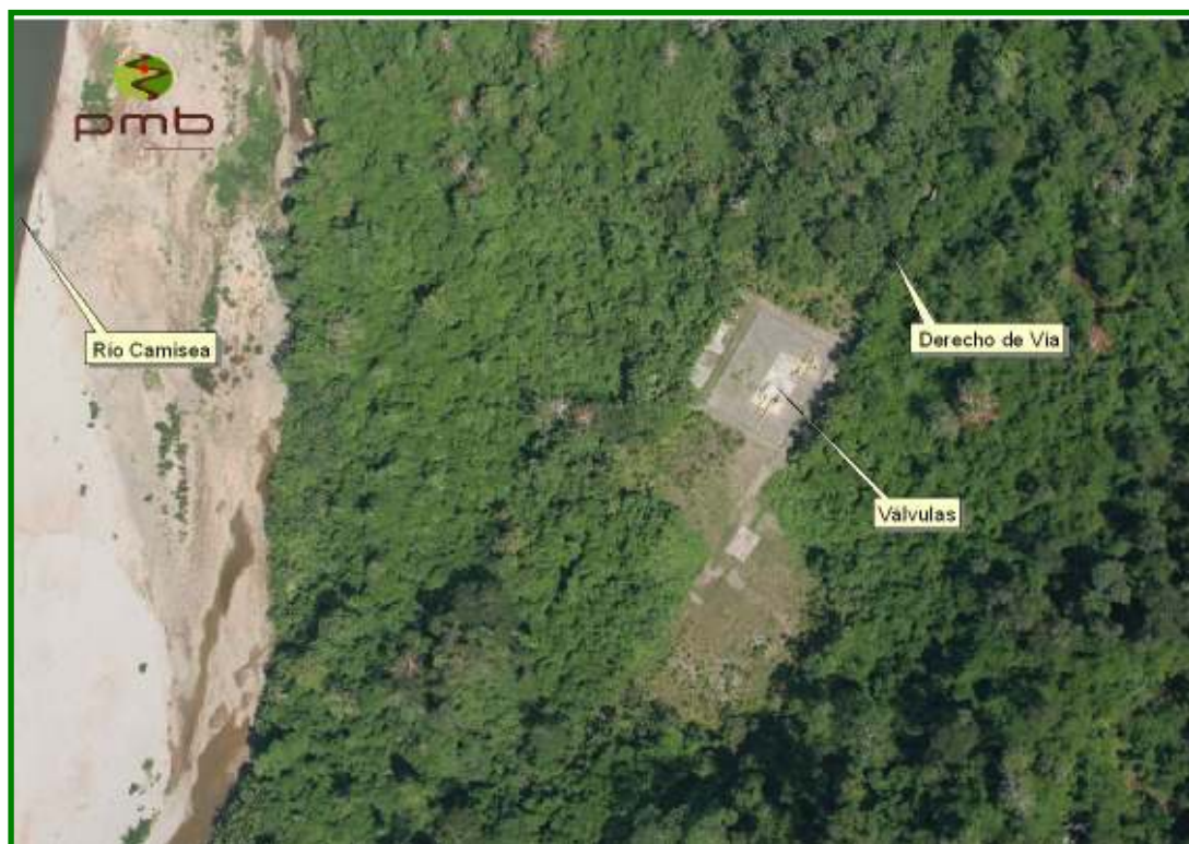
Figura 13. Fotografía Aérea Flowline Malvinas-San Martín 3 (Kp20). Sector de válvulas cercano a la comunidad de Segakiato.
