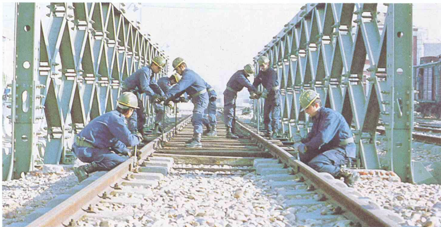
Colocación de traviesas y cupones.
