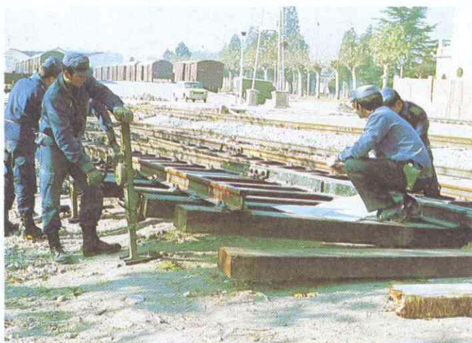
Colocación de traviesas y cupones.
