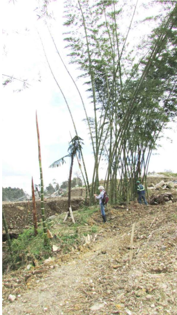
Foto 4. Guadual afectado por la construcción de la vía.
