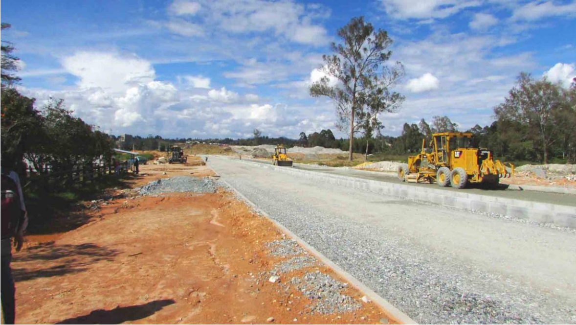
Foto 2. Vía en construcción al interior del lote de interés.
