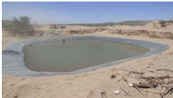
Fotografía 4.7. Estanque para almacenamiento de agua
