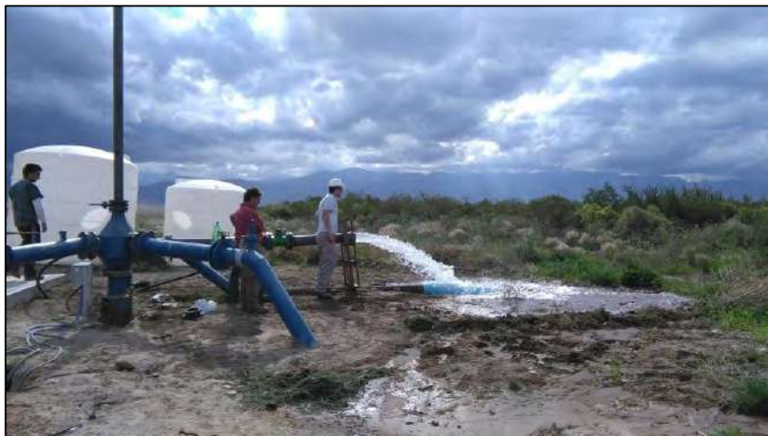
Fotografía 8.2. Caudal erogado y aforado mediante caudalímetro totalizador.
