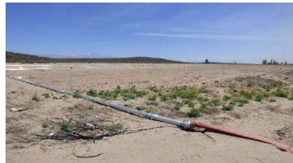
Fotografía 4.8. Campo experimental regado con agua superficial
