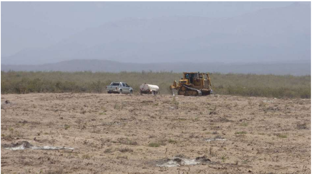
Fotografía 4.4. Actividades de acondicionamiento del terreno
