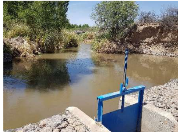
Fotografía 4.6. Obra de captación de agua
