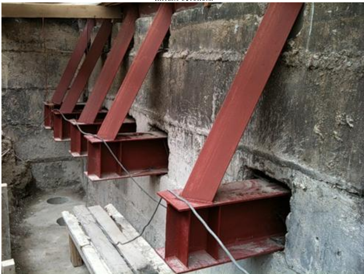
Рис. 2. Уширение ленточных фундаментов монолитными банкетами.
