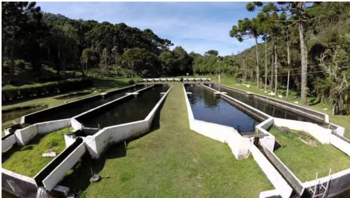
Figura 4. Tanques de cultivo da truta arco-íris na Unidade Particular (UP) na cidade de Campos do Jordão. Fonte: Ph7 Filmagens Aéreas
