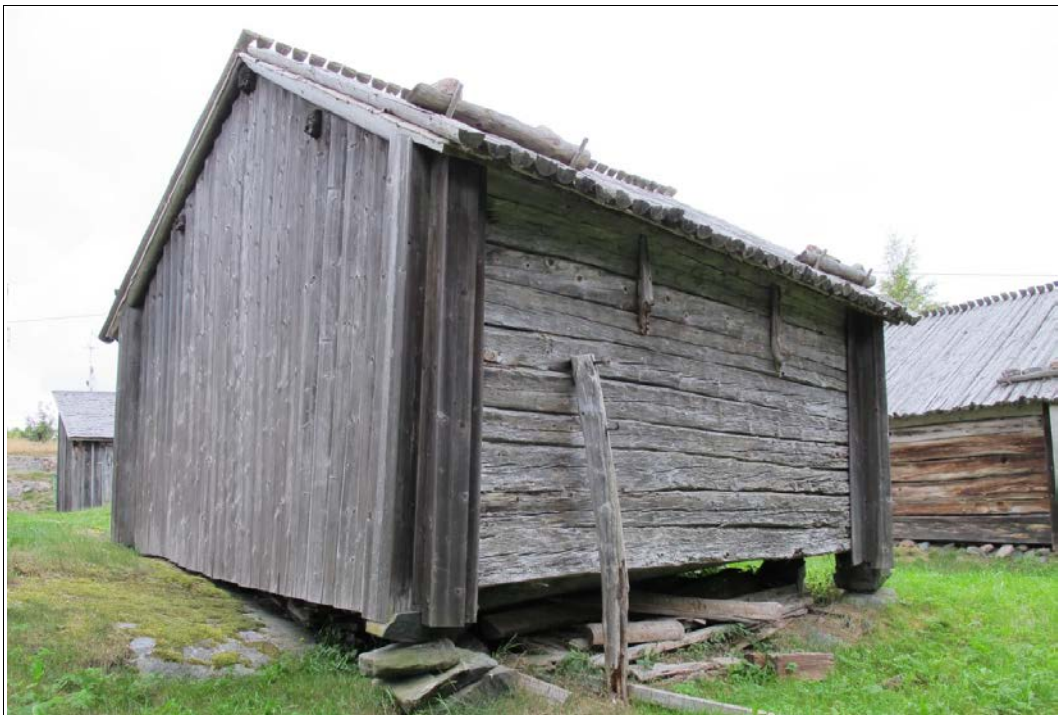
Figur 2. Delvis bruk av kledning gir en god beskyttelse av de mest fuktbelastede delene av lafteveggene.
