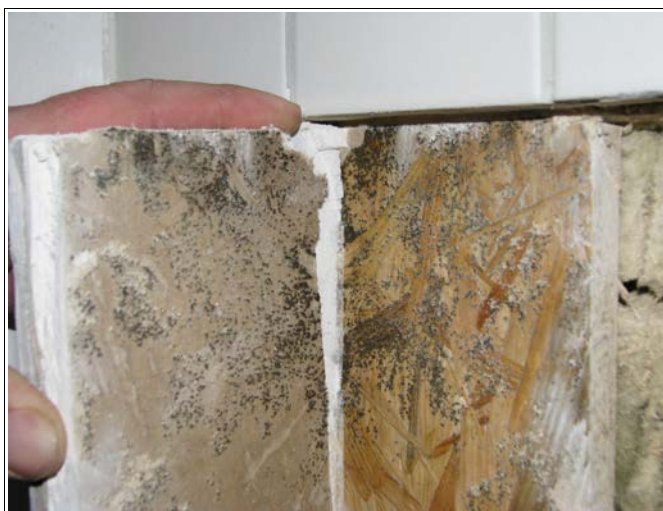
Figur 2. Kraftig vekst av raggråtemugg i en dusjvegg. Extensive growth of Chaetomium globosum in a shower wall. Foto: Mycoteam as.
