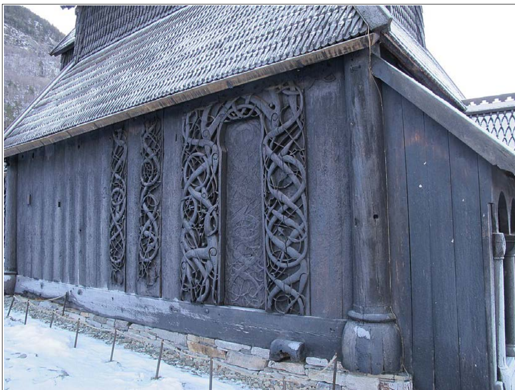
Figur 1. Nordportalen på Urnes stavkirke er fremdeles uten råtesoppkader, etter ca. 1.000 års eksponering for vær og vind!
