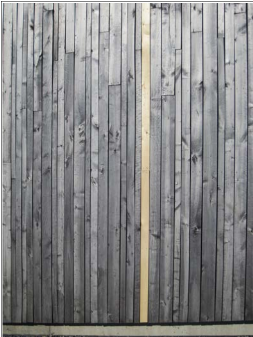
Figur 1. Ubehandlet osp som utvendig kledning. Untreated Aspen as cladding in an external wall. Photo: Lone Ross Gobakken.
