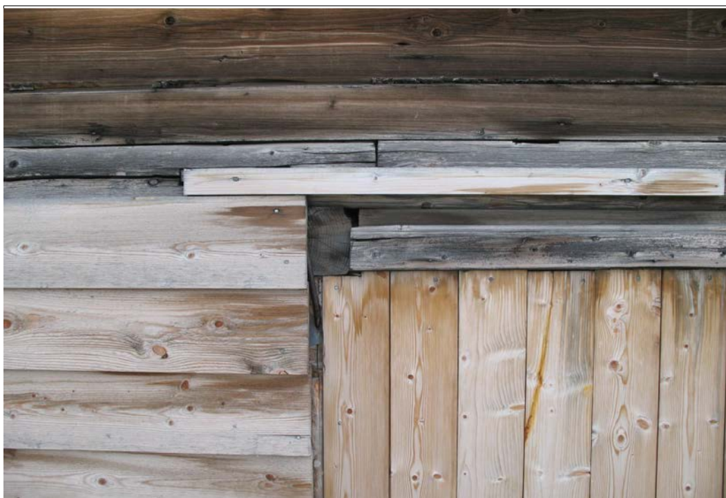
Figur 2. Vekst av svertesopp skjer gradvis på nye trematerialer, særlig i forbindelse med direkte fuktbelastet treverk.
