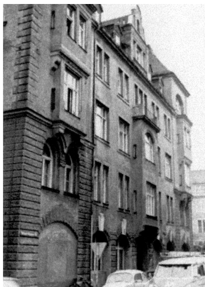
LRZ im Gebäude Richard-Wagner-Straße 18
