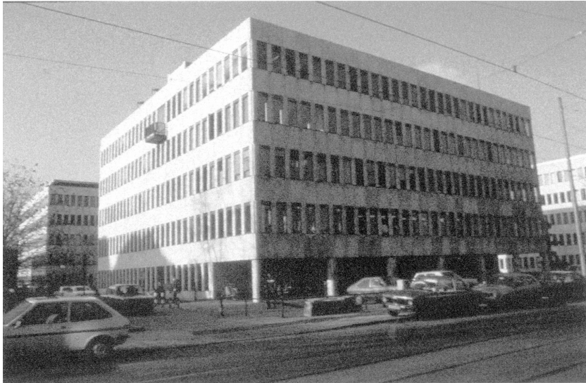
LRZ-Gebäude Barer Straße 21
