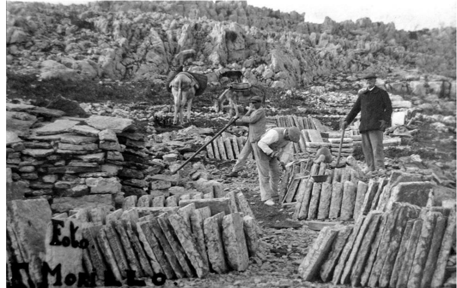
Canteros extrayendo losas de caliza nodulosa (1922) para el suelo de la ermita de Cabra (foto de Concha García López, Cabra en el recuerdo ).
