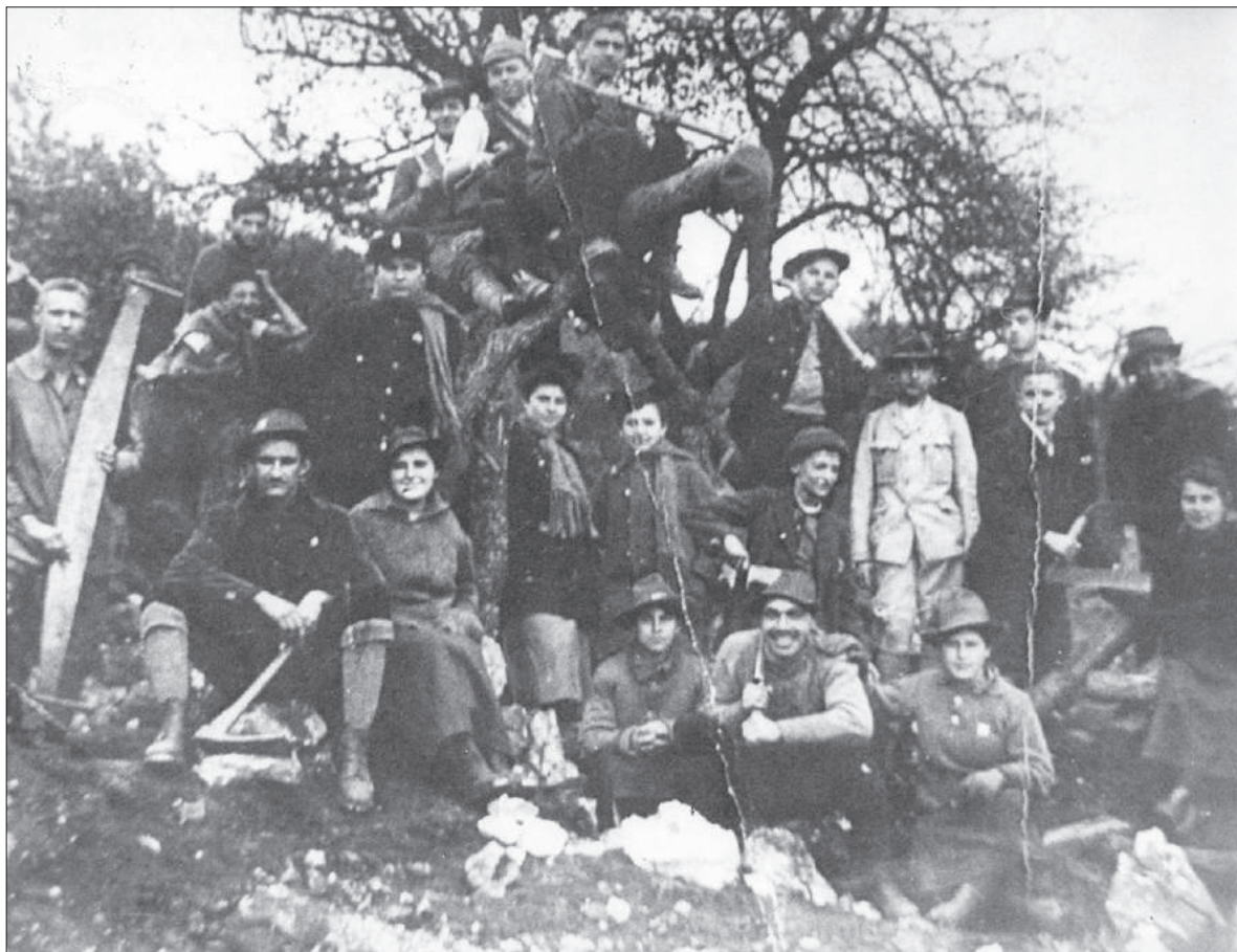
A pilis-tetői turistabázis építése 1920 körül
