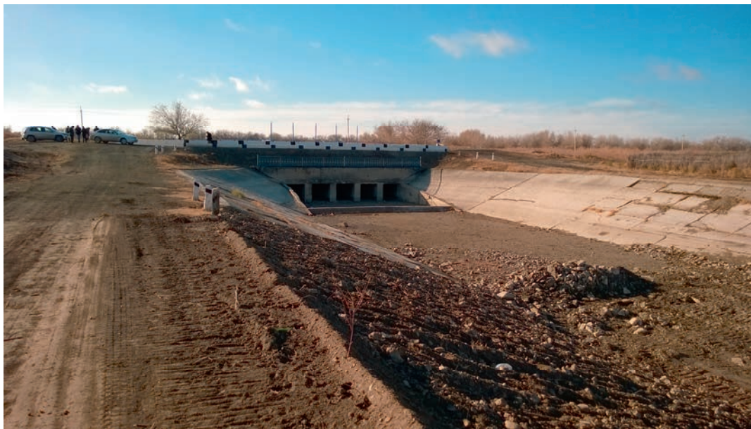
Фотография 11.6: Головное сооружение канала Муйнак из Междуреченского водохранилища
