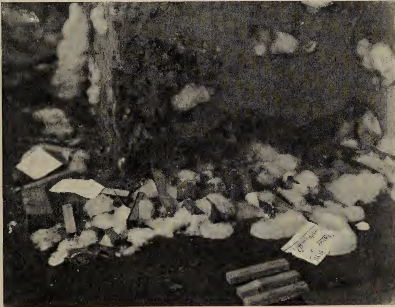
Fig. 1. Merulius -Ansteckungsversuche im Keller. Wiedergabe der Versuchsanordnung (Hausschwammecke). — Hölzer in Berührung mit den Schwammrasen werden von denselben angesteckt; im Vordergrund drei Holzstücke, auf denen die von jenen übertragenen Mycelflocken dagegen nicht anwachsen. Seite 329 des Textes, Versuch 5, p. 331. (Stark verkleinerte Photographie; Expositionsdauer 15 Min. bei künstlichem Licht.)
