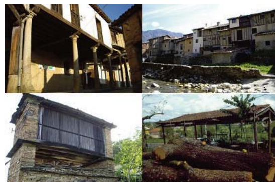
Fig. 4: Costruzioni con legno di castagno a Yuste ed Ávila (sopra a sinistra) in Hervás, Cáceres (sopra a destra); magazzino per la birra (in basso a sinistra) e tronchi per lavorazione in Galicia (in basso a destra). Fig. 4: Chestnut timber in buildings, as in houses (Yuste, Ávila, above left); Hervás, Cáceres, above right and, traditional storage barns (bottom left). Grafted trees cut down for logs in Galicia (bottom right).
