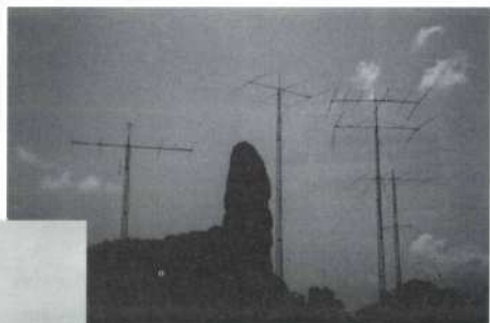
Bilden ovan: André har sex antenntorn med bl.a. monobands yagi för 7, 10, 14, 21 och 28 MHz. Ett sjunde torn med yagi för 80 m är under uppförande.
