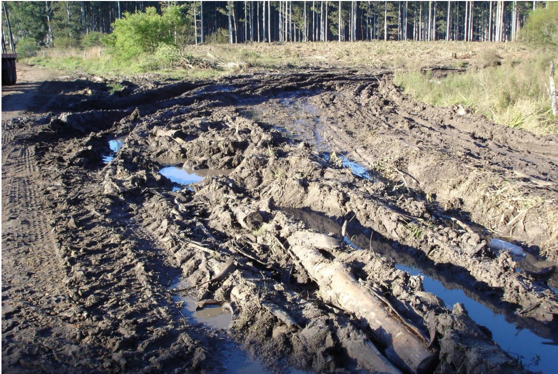
Figura 6-5: Caminos vecinales afectados por el tránsito de vehículos en época de lluvias.
