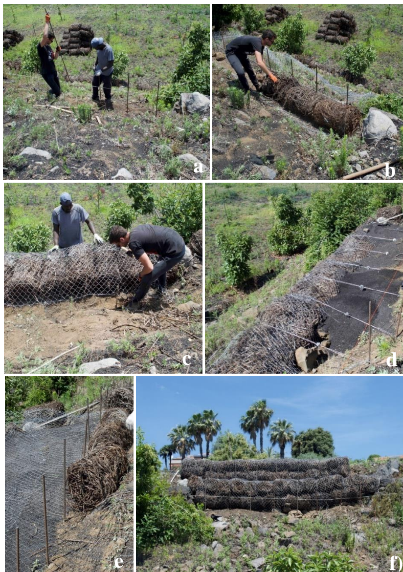
Figura 3.73 Messa in opera Prototipo B1; a) infissione picchetti di sostegno, b) posa delle RFM nella rete, c) chiusura del sacco d) tiranti dei picchetti di valle e riempimento, e) posa fascinata di monte, f) opera finita.
