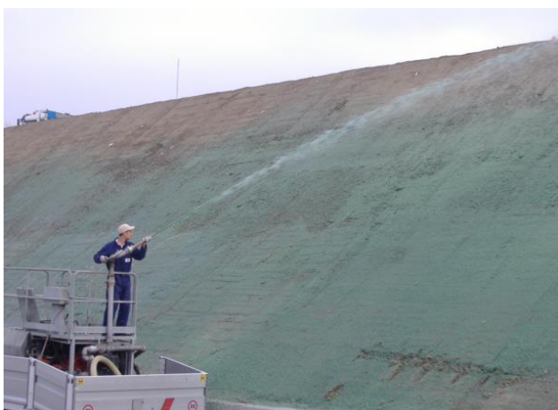
Figura 2.21 Applicazione idrosemina potenziata.
