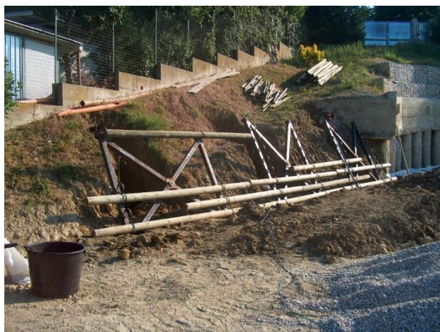
Figura 3.55 Palificata loricata Roseto degli Abruzzi 2010, durante i lavori a sinistra ed a fine lavori a destra (foto Crocetti C.).
