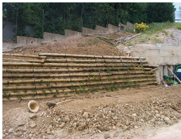
Figura 3.55 Palificata loricata Roseto degli Abruzzi 2010, durante i lavori a sinistra ed a fine lavori a destra (foto Crocetti C.).
