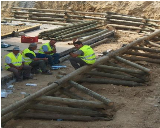
Figura 3.44 Palificata latina L'Aquila, 2009 (foto Crocetti C.).
