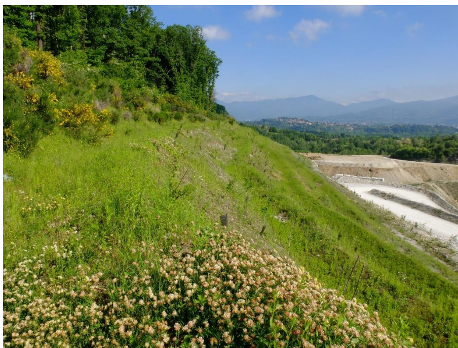
Figura 2.34 Scarbate ripristinate dopo 4 anni dall'intervento di inerbimento con fiorume, mantenuta con un intervento di sfalcio all'anno. Si rileva una ricca presenza di specie tipiche dei prati locali con abbondante fioritura di Anthyllis vulneraria in primo piano (foto A. Ferrario).
