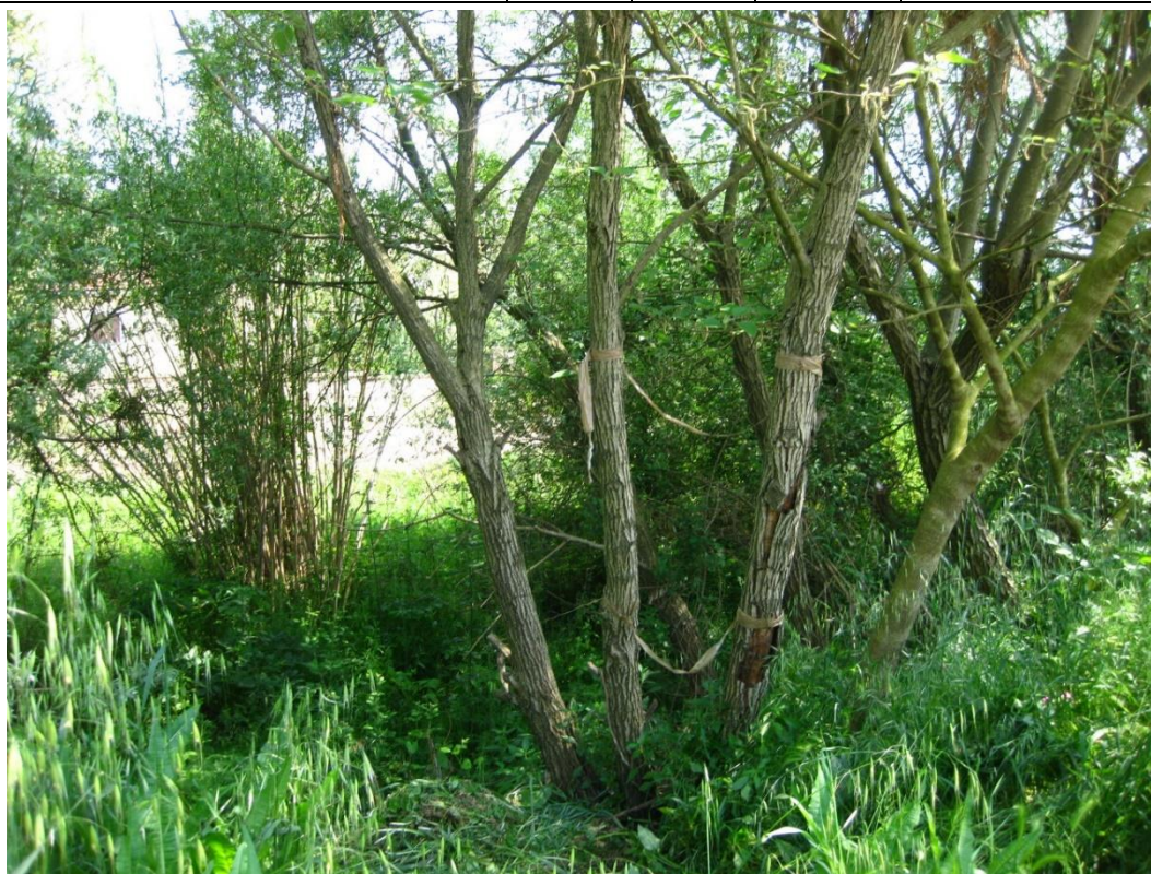
Figura 5.6 Sviluppo di talee della palificata viva dopo 14 anni. S. Pasquale Rio Inferno (FR). 2014
