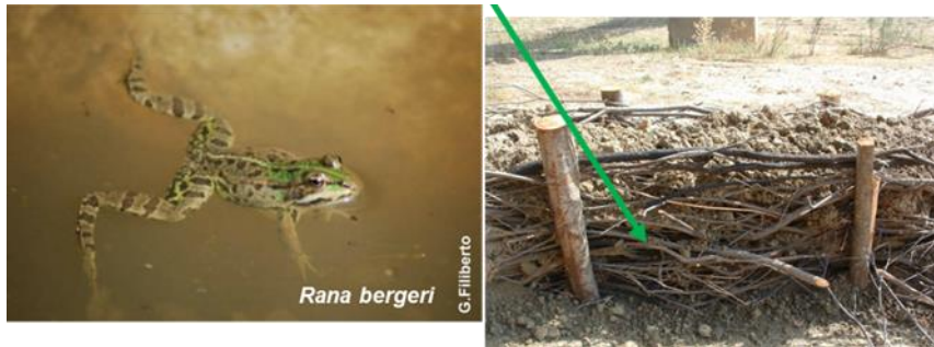
Figura 4.45 Realizzazione di repellenti vivi per la creazione di aree di ristagno nei periodi di magra, a beneficio soprattutto della bracofoauna e dei limicoli.
