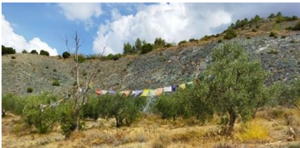
Figura 3.18 Area di cava oggetto di intervento.
