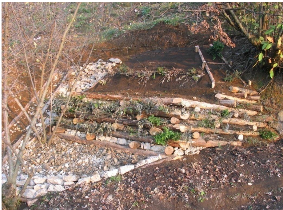
Figura 3.77 Mitigazione rischio idrogeologico – Moschiano (AV) 2004 (Gradonata mista con talee e piantine e Palificata viva doppia).
