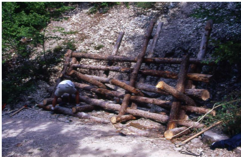
Figura 5.12 Fase di realizzazione della palificata Roma (2000).
