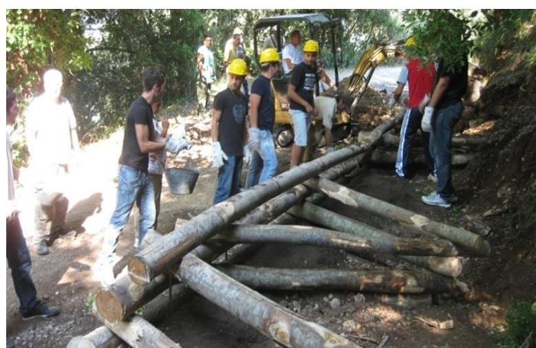
Figura 3.50 Palificata latina nei Cantieri didattici Corso Ingegneria Naturalistica. Scuola Geometri Tallini Formia 2010 (foto Cornellini P.).
