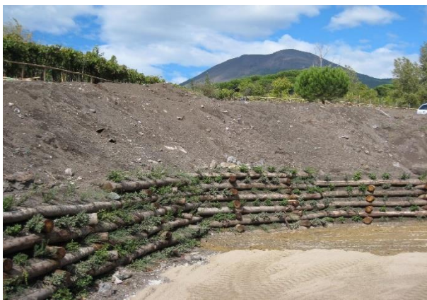
Figura 3.42 Palificata latina a lavori ultimati sotto il Vesuvio 2007 (foto Cornelini P.).
