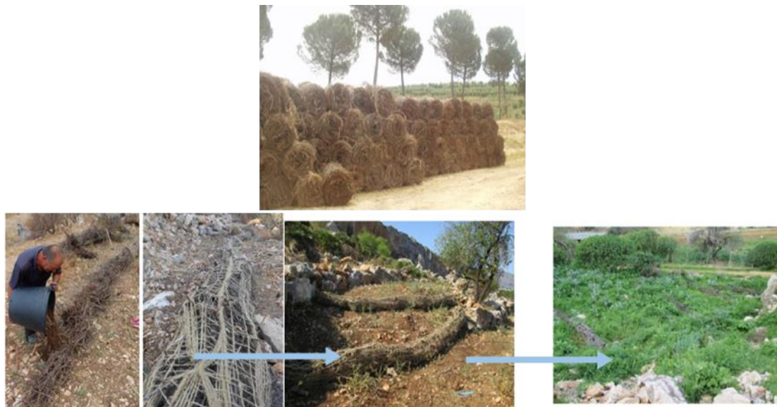
Figura 1.23 Realizzazione di biorulli, posa in opera e successivo inverdimento. (Parco Portella del Cerriolo, Custonaci 2014).
