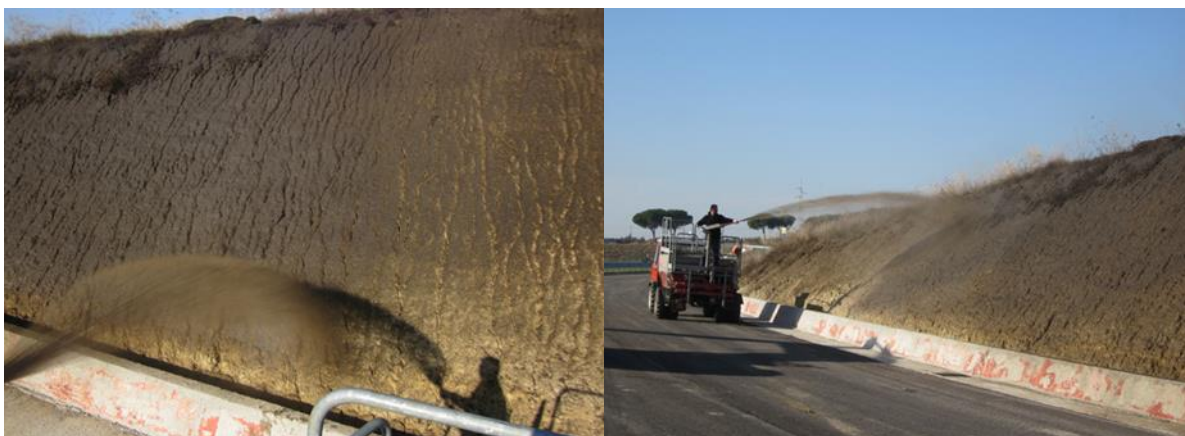
Figura 2.25 Applicazione ABI su scarpata con idonei ugelli a “V”.
