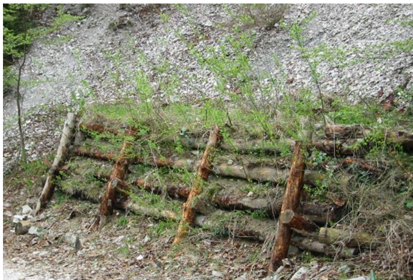
Figura 5.14 Palificata Roma alla quattordicesima stagione vegetativa, interamente vegetata.
