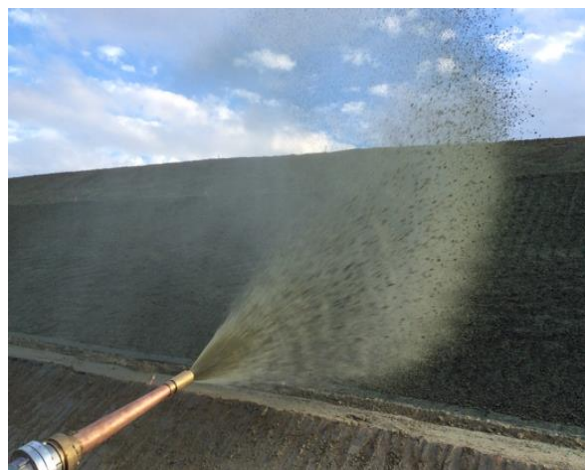
Figura 2.20 Distribuzione idrosemina ed applicazione.
