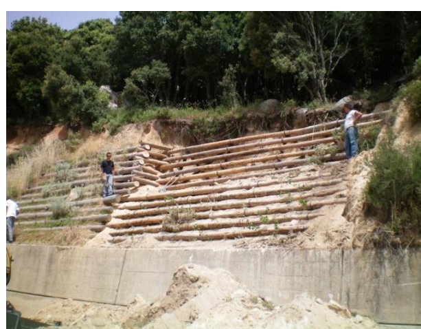
Figura 3.55 Palificata loricata Roseto degli Abruzzi 2010, durante i lavori a sinistra ed a fine lavori a destra (foto Crocetti C.).
