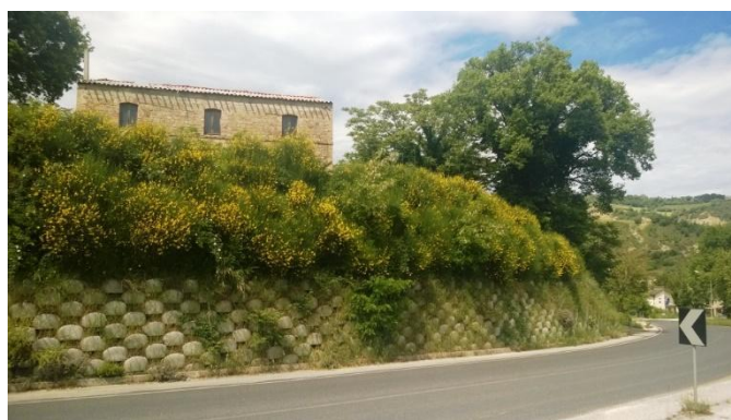
Figura 3.57 Palificata loricata (PS) nel 2011 e 2014 (foto Marrone E.).
