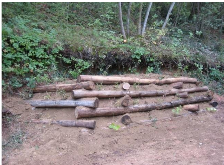
Figura 2.9 Inserimento di arbusti autoctoni in una palificata latina. Cà i Fabbri (PU) 2007 (foto Cornelini P.)
