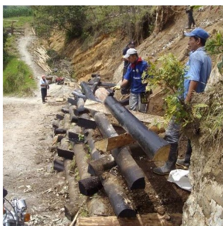
Figura 3.51 Palificata Latina a Coconuco_ Colombia –2011 (foto Crocetti C.).
