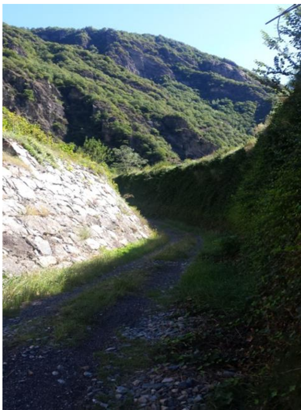
Figura 3.88 Mitigazione rischio idrogeologico - Arnad (AO), foto G.Doronzo (Vallo paramassi costituito da terra rinforzata rinverdita) 2017.
