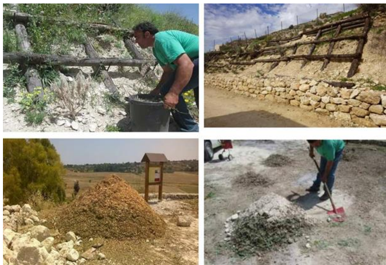
Figura 2.43 Realizzazione grata viva e produzione di tecnosuolo (2014).
