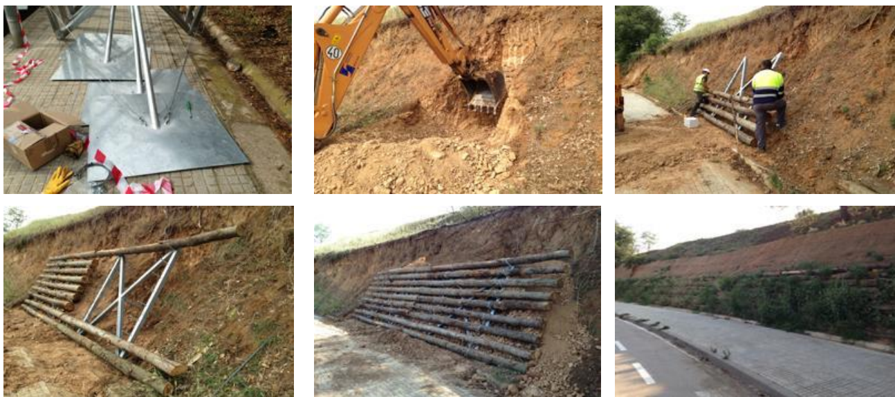
Figura 3.58 Versione della loricata realizzata in Spagna (foto Sorolla)
