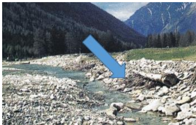
Figura 1.16 Alberi grezzi utilizzati anche come opere di difesa spondale. In foto un esempio nel greto del torrente Vizze presso San Giacomo (Alto Adige). Fonte Florineth F. (2007).
