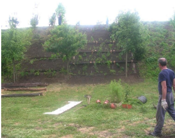
Figura 3.82 Riqualificazione urbana - Parco Urbano Pomigliano D'Arco (NA) (Grata viva e gradonata viva )2005.
