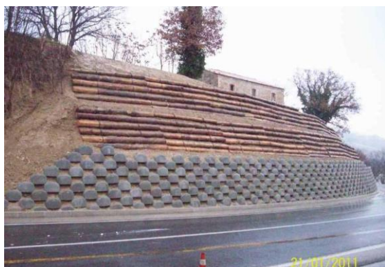
Figura 3.57 Palificata loricata (PS) nel 2011 e 2014 (foto Marrone E.).
