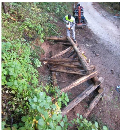
Figura 3.47 Palificata latina 2007 Parco del Furlo (PU) (foto Cornellini P.)
