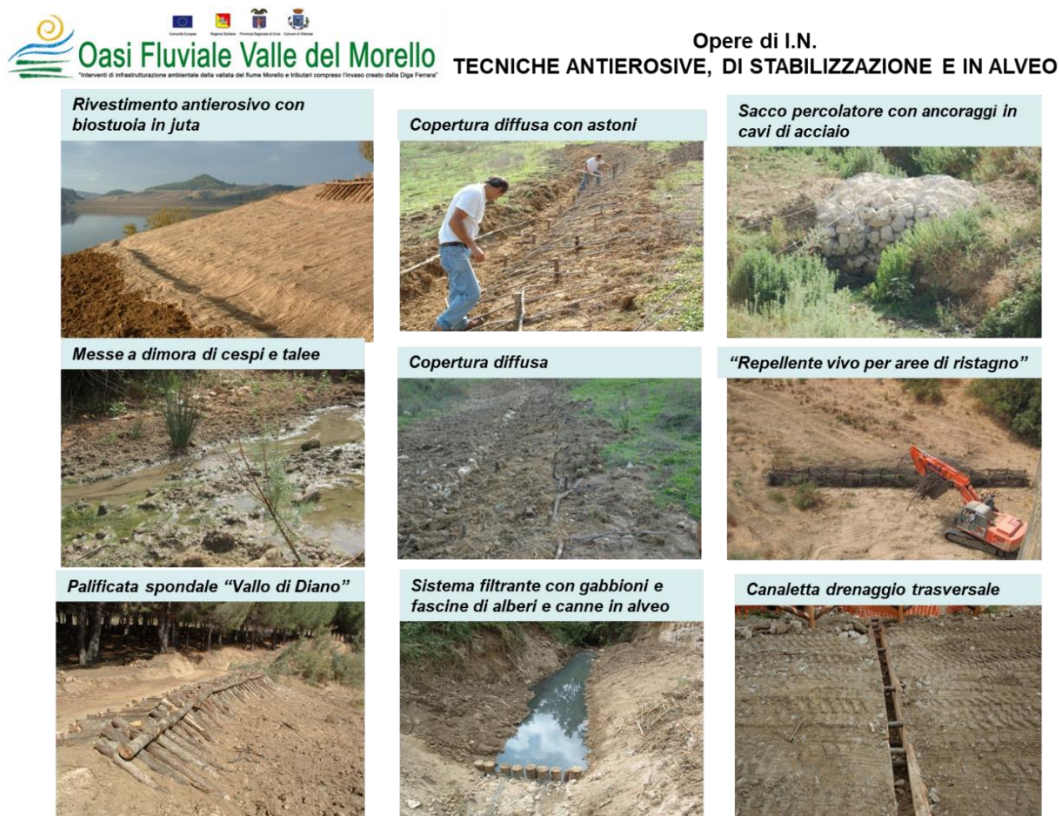
Figura 4.46 Principali tecniche di ingegneria naturalistica impiegate.
