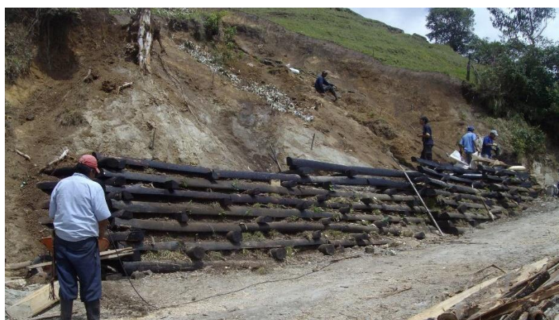
Figura 3.51 Palificata Latina a Coconuco_ Colombia –2011 (foto Crocetti C.).
