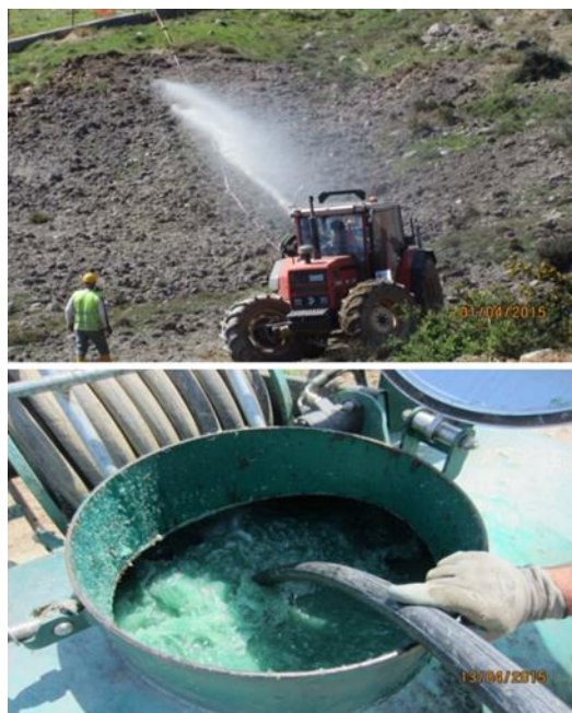
Figura 3.8 Idrosemina naturalistica per il ripristino della discarica di Termini Imerese (Palermo, 2015).
