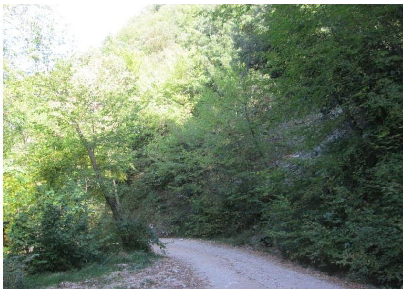
Figura 5.13 Palificata Roma alla seconda stagione vegetativa.
