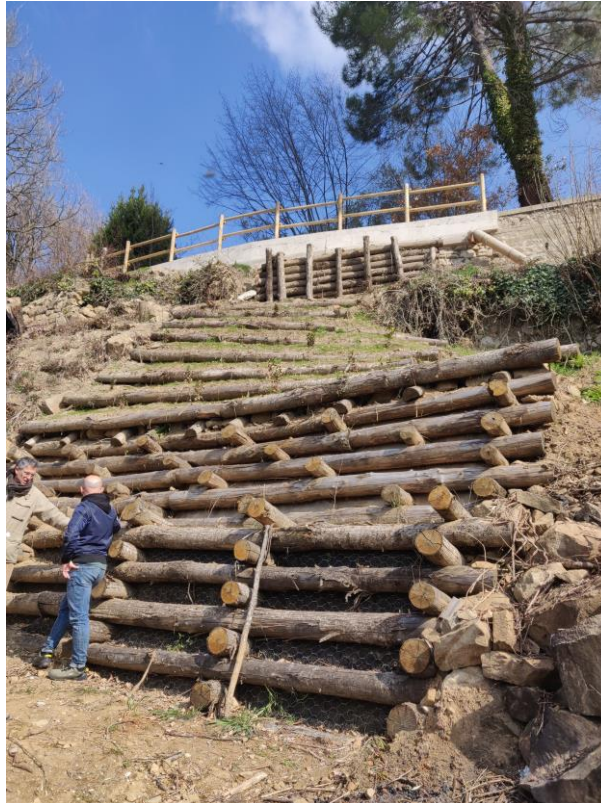
Figura 7.12 Opera di Ingegneria Naturalistica realizzata.
