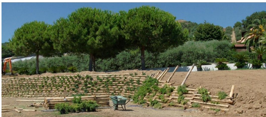
Figura 3.36 Palificata Roma senza palo frontale Martinsicuro (TE) (foto Cornelini P.).
