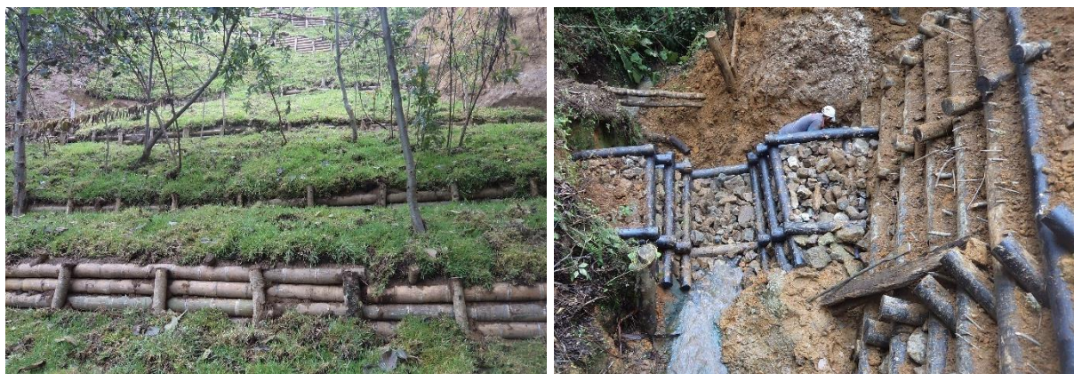
Figura 3.95 e Figura 3.96 Sistemazioni di bacino realizzate da tecnici e maestranze locali, 2013 2014- (COL).
