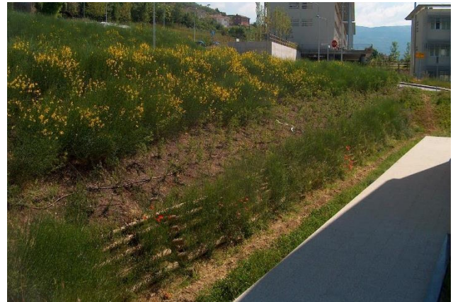
Figura 3.43 Palificata latina L'Aquila dopo un anno, 2010 (foto Crocetti C.).
