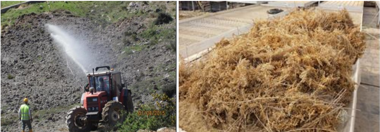
Figura 1.34 Idrosemina naturalistica con semi ad alto valore biotecnico (Discarica di Termini Imerese, Palermo. 2015) a sinistra, fiorume di Artemisia arborescens (Custonaci, 2014) a destra.
