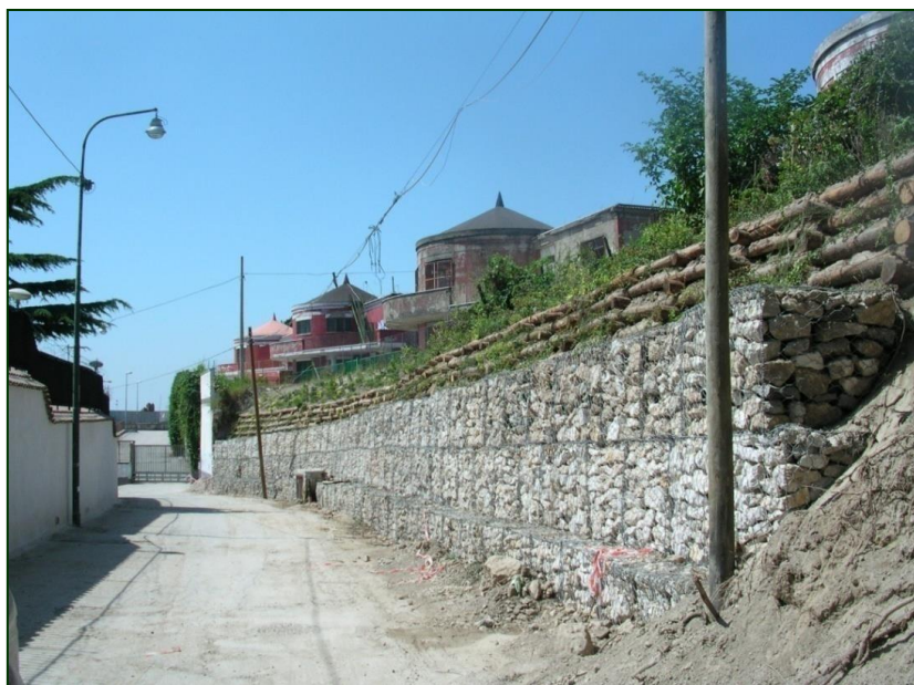
Figura 3.81 Mitigazione rischio idrogeologico – Marano di Napoli (NA) 2011 (Gabbionata rinverdita, Gradonata mista con talee e piantine e Palificata viva doppia – Progetto e Direzione Lavori: Arch. E. Cozzolino – Geol. G. Doronzo).
