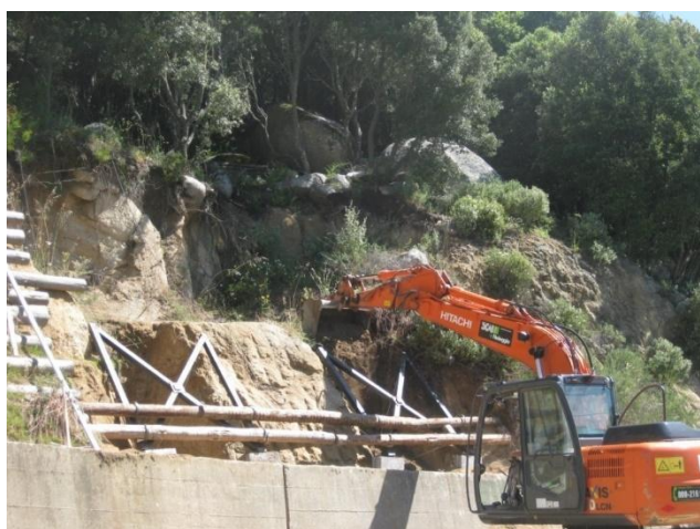
Figura 3.55 Palificata loricata Roseto degli Abruzzi 2010, durante i lavori a sinistra ed a fine lavori a destra (foto Crocetti C.).
