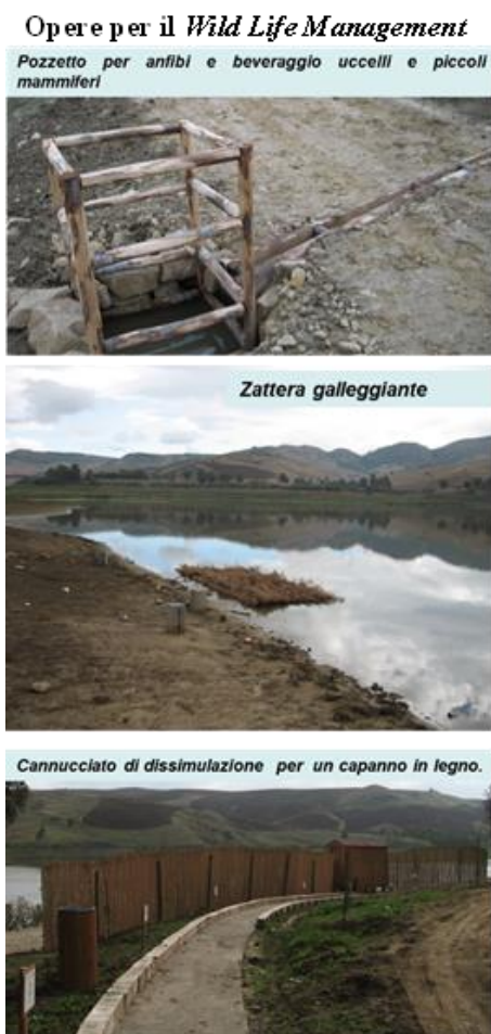
Figura 4.44 Interventi per il Wild Life Management: Zattere galleggianti , pozzetto di beveraggio per anfibî, uccelli e piccoli mammiferi, cannucciato di dissimulazione per un capanno in legno.
