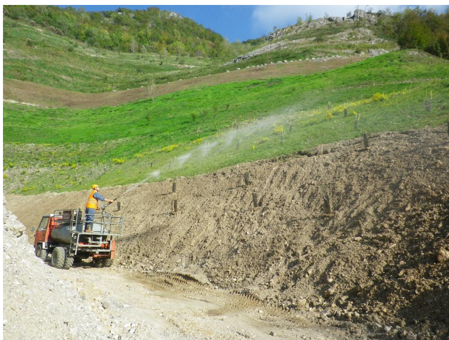
Figura 2.33 Inerbimento di scarpata in cava con idrosemina di fiorume (foto A. Ferrario).
