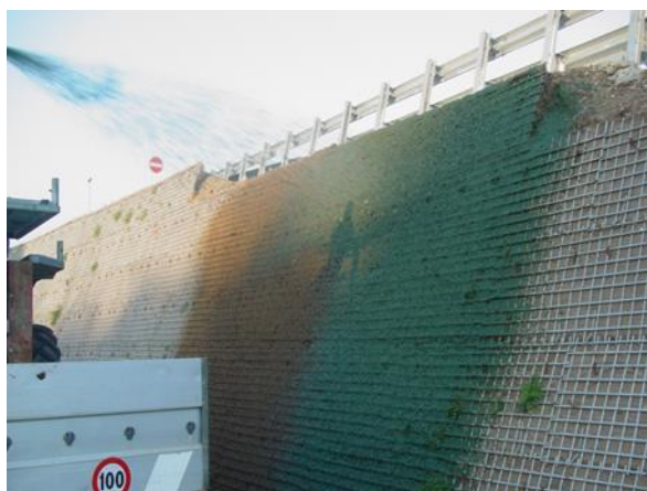
Figura 2.23 Applicazione idrosemina a spessore secondo passaggio.
