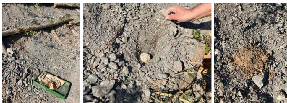
Figura 3.25 Posa in opera Seed Balls - Stazione grata viva.
