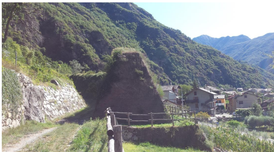
Figura 3.87 Mitigazione rischio idrogeologico - Arnad (AO), foto G.Doranzo (Vallo paramassi costituito da terra rinforzata rinverdita) 2017.
