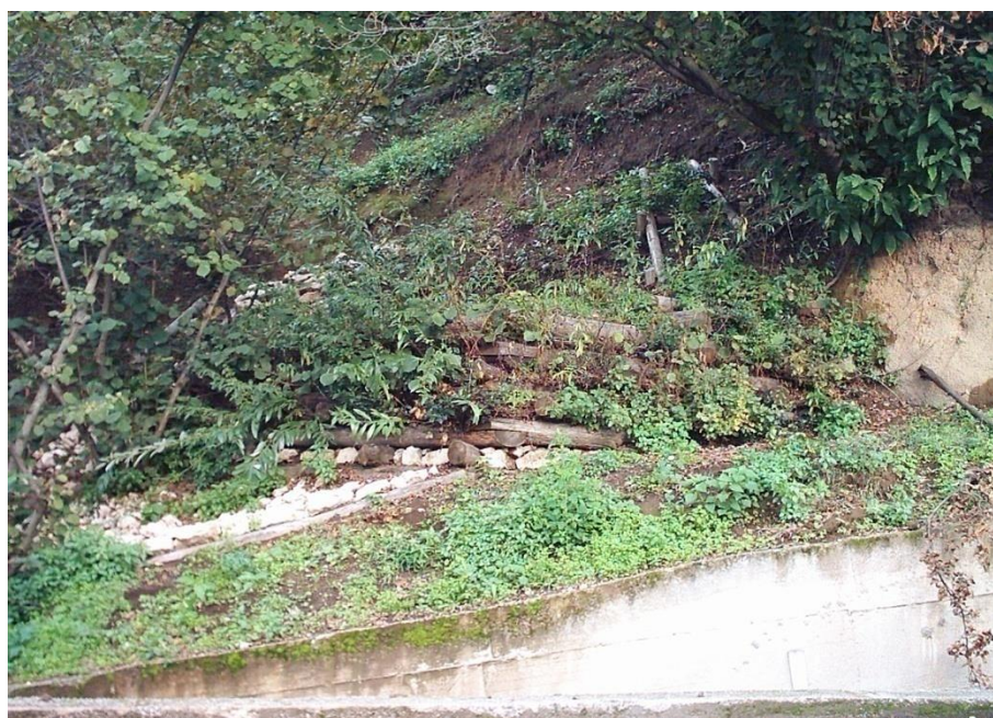
Figura 3.78 Mitigazione rischio idrogeologico – Moschiano (AV) 2005 (Gradonata mista con talee e piantine e Palificata viva doppia).
