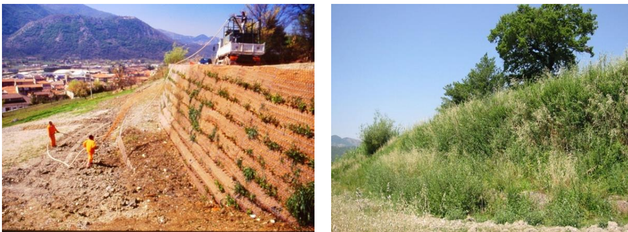
Figura 2.11 La miscela delle sementi dell'idrosemina viene definita, in base alla capacità di formare un rivestimento rapido e continuo e di migliorare il terreno, in attesa che le specie spontanee dell'area colonizzino le superfici. Intervento di idrosemina su terra rinforzata stradale. Atina (FR) 2001 (foto Cornelini P.). A destra intervento dopo 1 anno.
