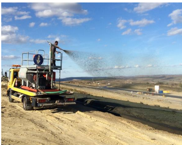
Figura 2.20 Distribuzione idrosemina ed applicazione.
