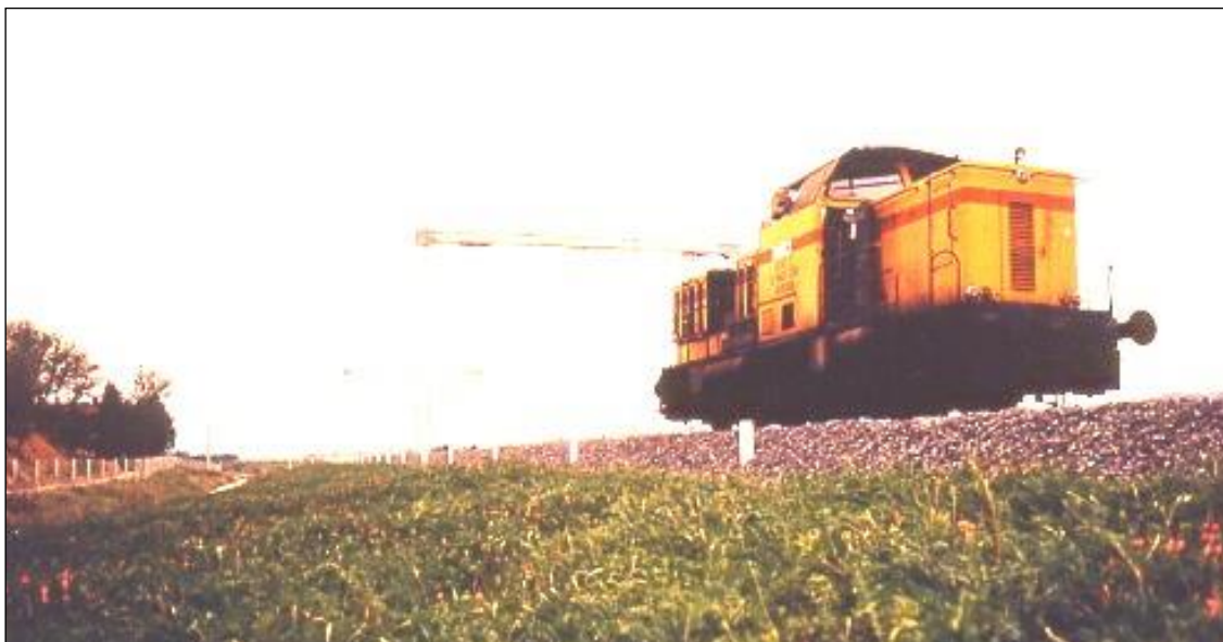
Figura 2.10 Interventi di idrosemina sulle scarpate della DD Roma-Firenze (AR) 1989. Dal Monitoraggio (1988-2001) degli interventi di idrosemina è emerso come l'inerbimento iniziale a leguminose ha consentito la successione dinamica e la dominanza della vegetazione autoctona (Cornelini, 2001).
