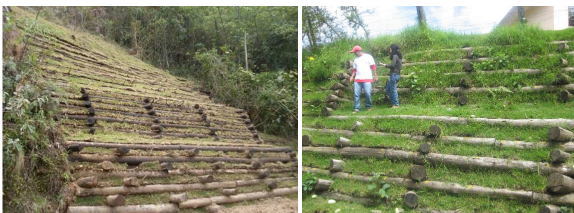
Figura 3.91 e Figura 3.92 Cantieri rurali realizzati con comunità locali, 2011-Popayan (COL).
