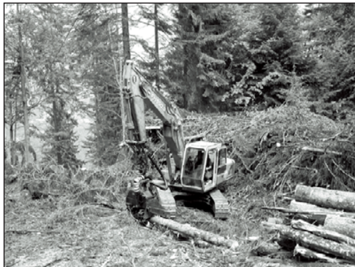
Figura 6. Braccio idraulico con testa allestitrice posizionata allo scarico di gru a cavo medio-pesante (Foto R. Spinelli).
