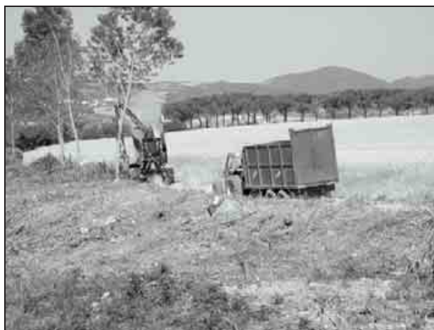
Figura 3. Lavori di sminuzzatura della vegetazione ripariale lungo sponda. Figure 3. Vegetation clearcut and chipping of the river's "Fine" banks. Figure 3. Coupe de la végétation riveraine.
