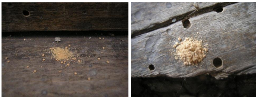
Fig.118. Scările dinspre cafas de la M-rea Frumoasa au fost distruse de Xestobium rufovillosum (după Moșneagu M., 2009)
