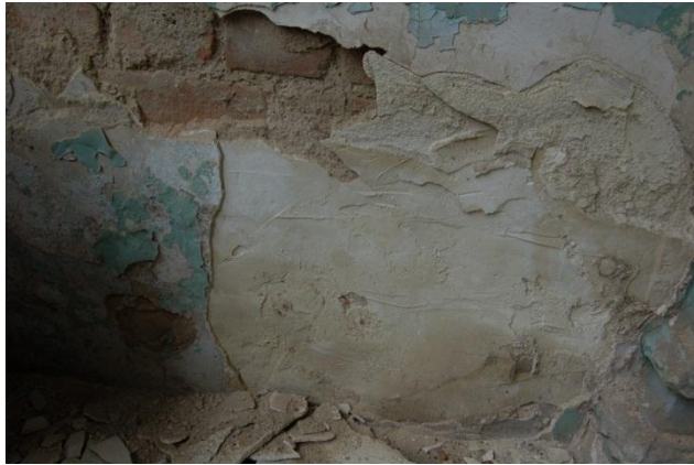
Fig.11. Cruste care se desprind datorită igrasiei (original)
