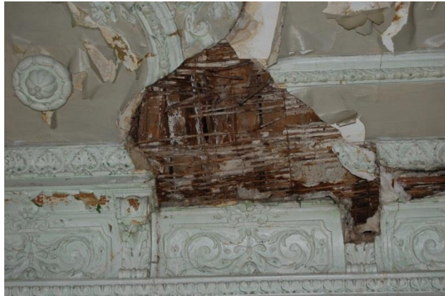
Fig. 96. O porțiune din tavanul unei camere dislocată ca urmare a atacului speciei Serpula lacrymans (original)
