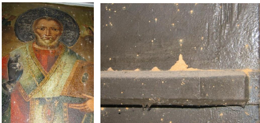
Fig.113. Rumeguș produs de Anobium punctatum scuturat din orificiile de zbor pe suprafețe (după Moșneagu M., 2009)
