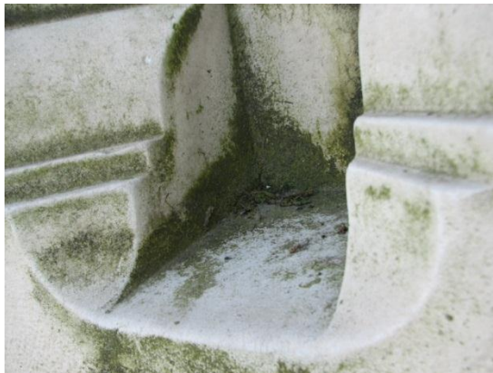
Fig. 30. Bioderma vegetală se dezvoltă de la bază pe ziduri provocând distrugerea zidului (după M. Mustață)
