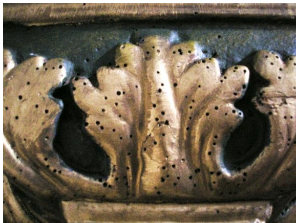
Fig. 109. Lemn atacat de A. punctatum (după Moșneagu M., 2009)
