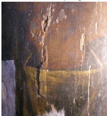
Fig. 190. Desprinderi ale picturii pe linia atacului unor insecte xilofage (foto Moșneagu M.)
