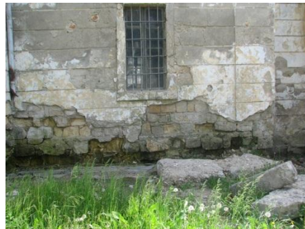
Fig. 98. Putregai brun produs în peretele unei case de Serpula lacrymans (original)
