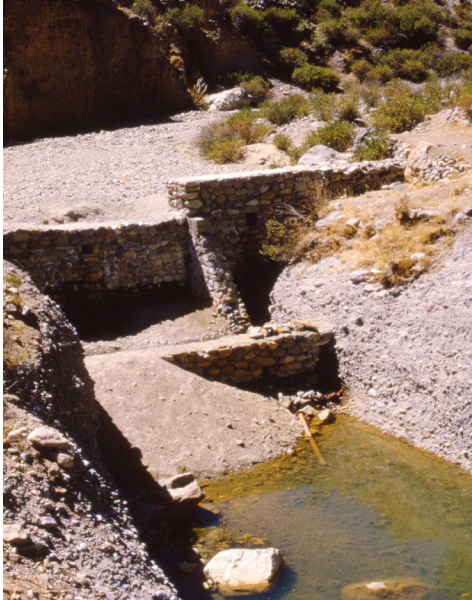
Obras de manejo de cuencas.
