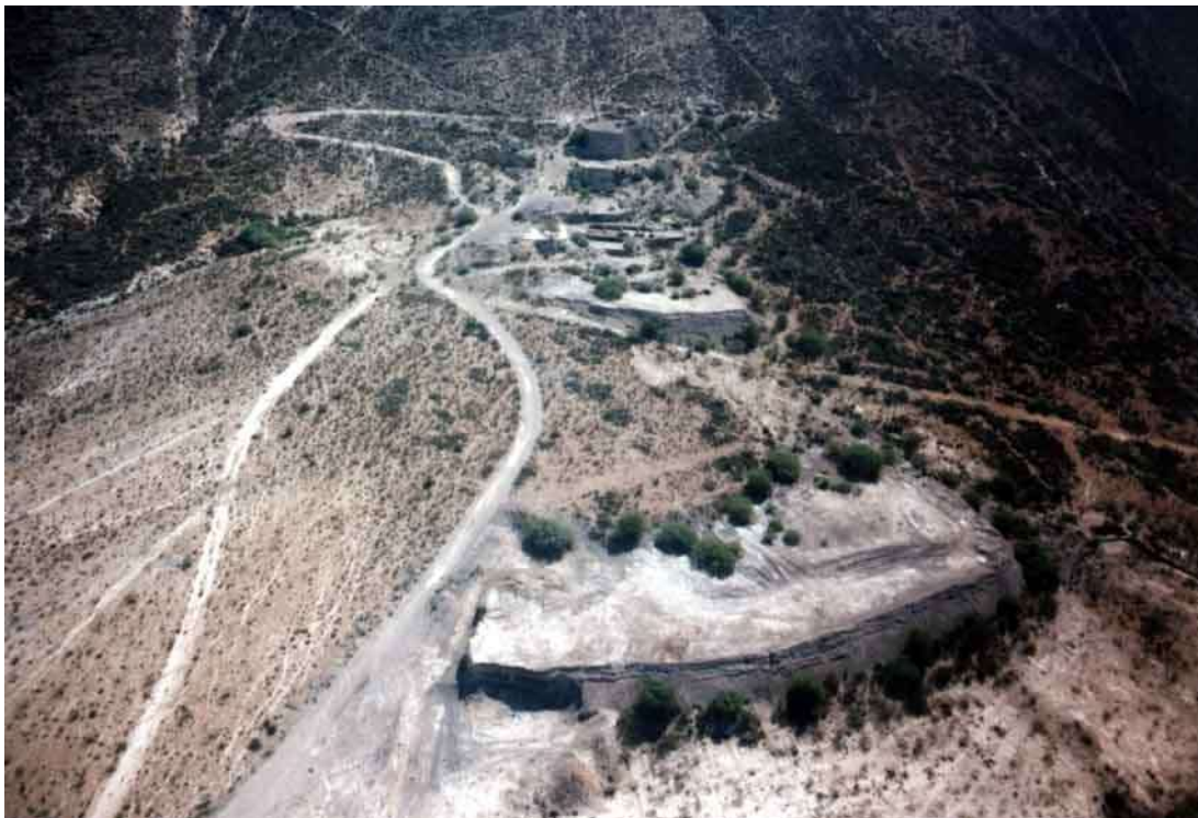
Antigua presa de jales derrumbada en el municipio de Melchor Ocampo.
