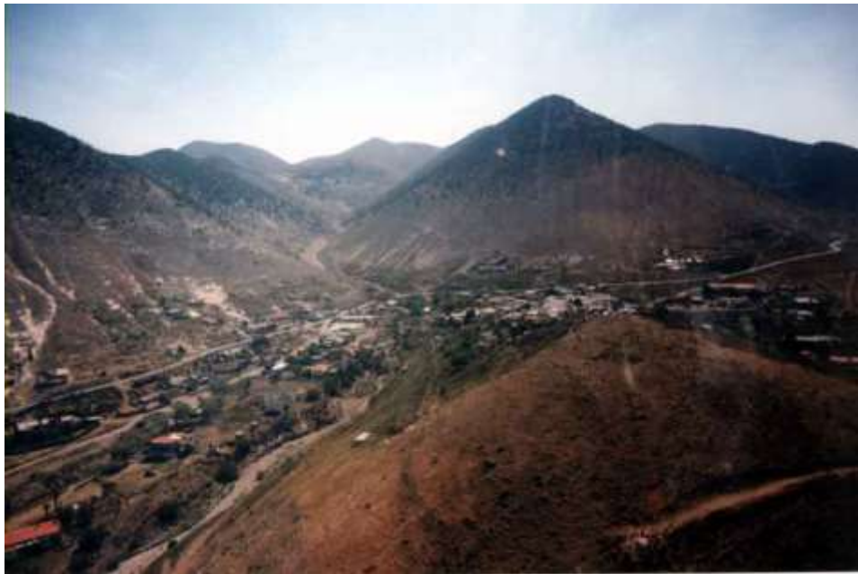
Impactos y deterioro causado por el asentamiento humano, una pequeña villa a partir de la actividad minera causa erosión por deforestación
