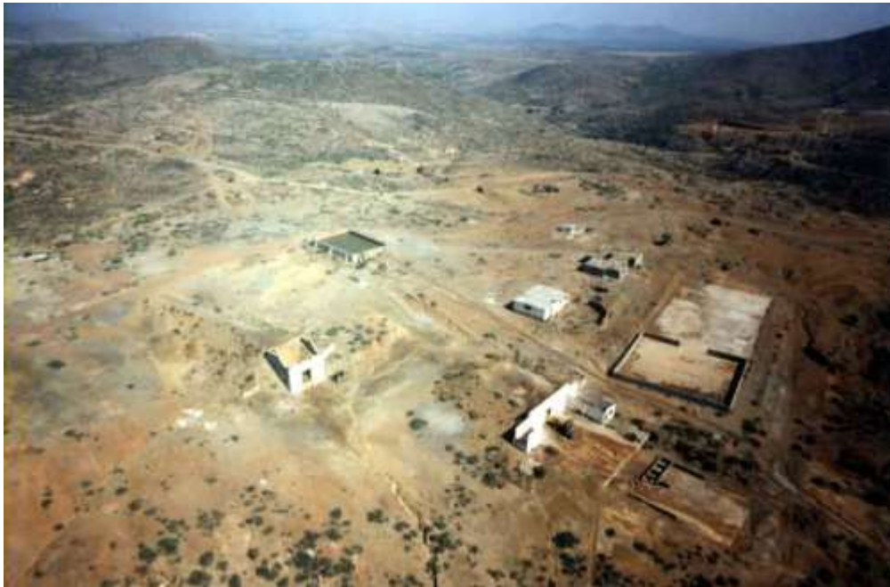
Veta Grande Zacatecas., impactos mineros después de doscientos años; erosión, grietas, pérdida de vegetación y ruinas.
