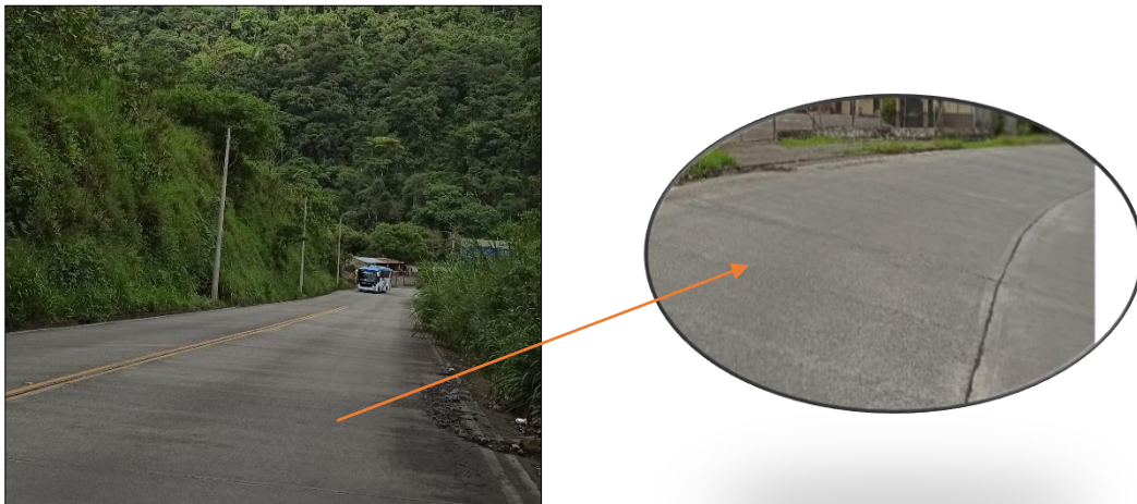
Foto 124. Capa de rodadura de Concreto (Hormigón Armado).
