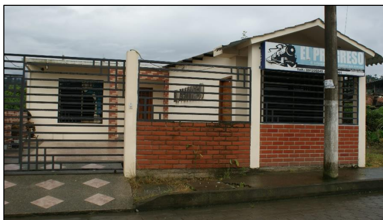
Foto 122. Instalaciones del Progreso Tv.
