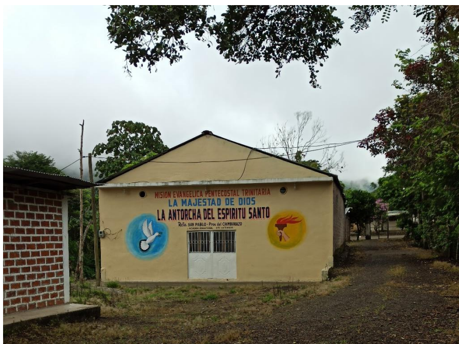
Foto 104. Recinto San Pablo
