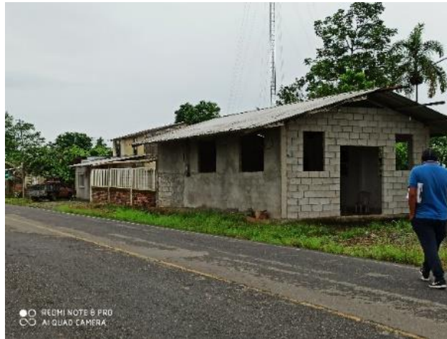
Foto 89. Sistema constructivo predominante en el sector urbano
