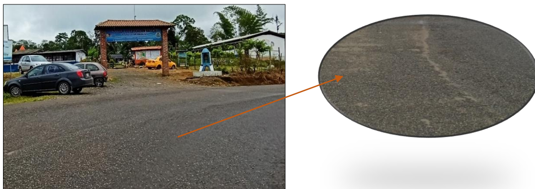
Foto 125. Capa de rodadura – Asfalto-Pavimento.
