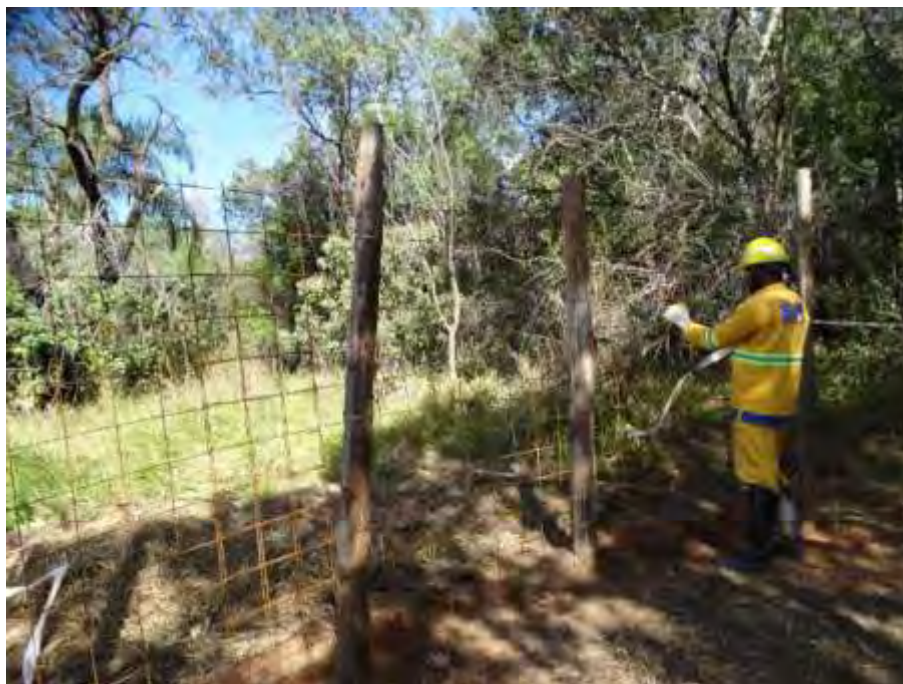
Foto 4.3-3: Fixação das telas de aço nas estacas de madeira
