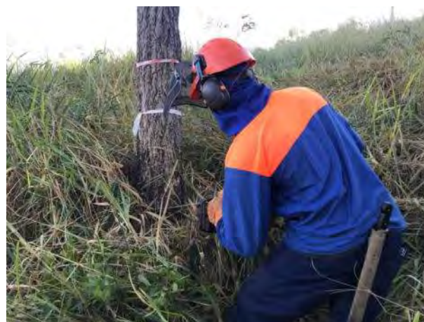
Foto 6 – Derrubada de árvores na área 50 (Registro fotográfico 17/06/2021)
