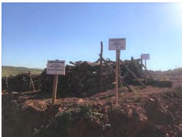
Foto 17 – Placas de sinalização local de enleiramento 03 (Registro fotográfico 28/06/2021).
