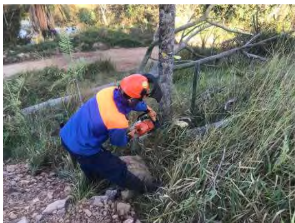
Foto 5 – Supressão Vegetal (Registro fotográfico 17/06/2021)
