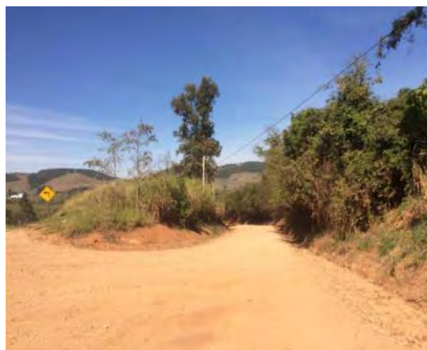
Foto 20 – Estrada de terra monitorada. (Data: 10/06/2021).
