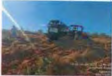
Foto 03 Trator dando apoio sub lote 8.10
