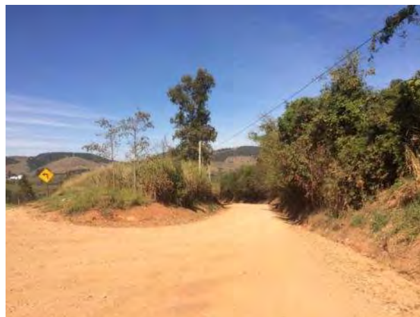
Foto 24 – Estrada de terra monitorada. (Data: 10/07/2021).
