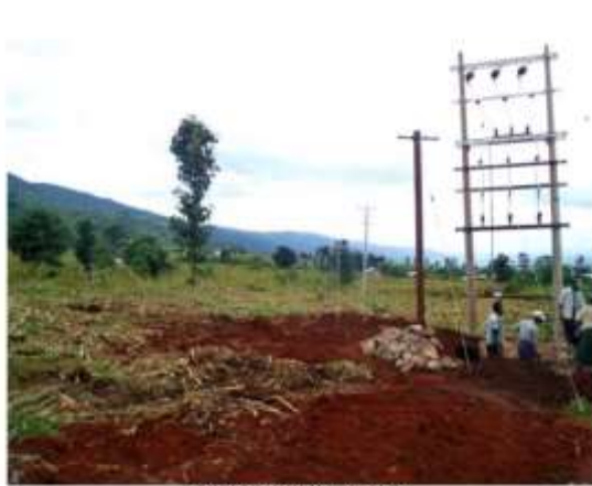
တံတိုက်ကျေးရွာလျှပ်စစ်မီးရရှိရေး Transformer တိုင်မည့်နေရာနှင့်မိတ်အားလိုင်
