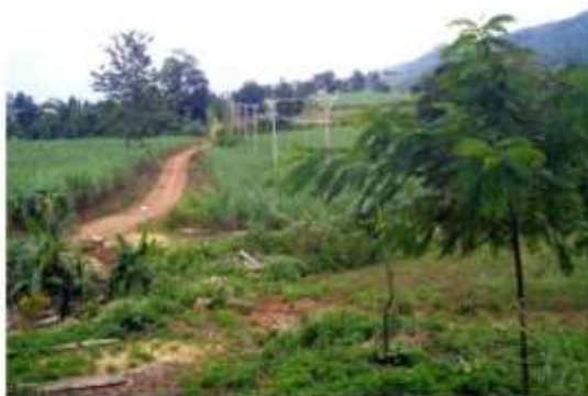
တံတိုက်ကျေးရွာလျှပ်စစ်မီးရရှိရေး 11KV မိတ်အားလိုင်
