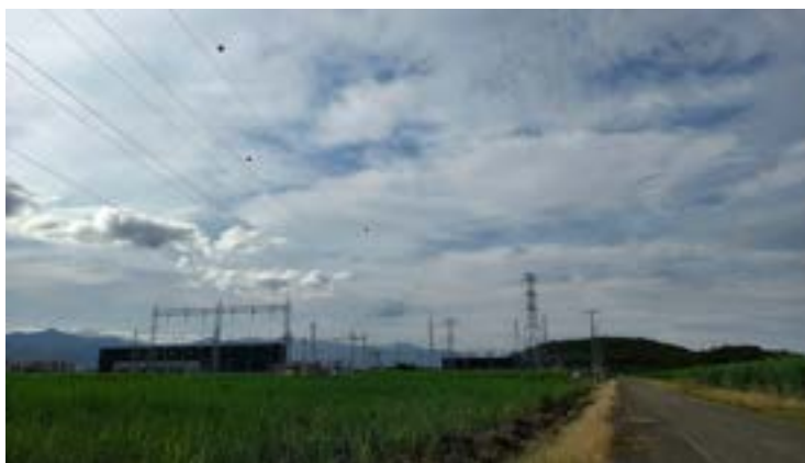
Fotografía 2. Zonas industriales o comerciales. Subestación Alférez. Municipio Santiago de Calí. E: 4611355,75; N: 1930850,31.
