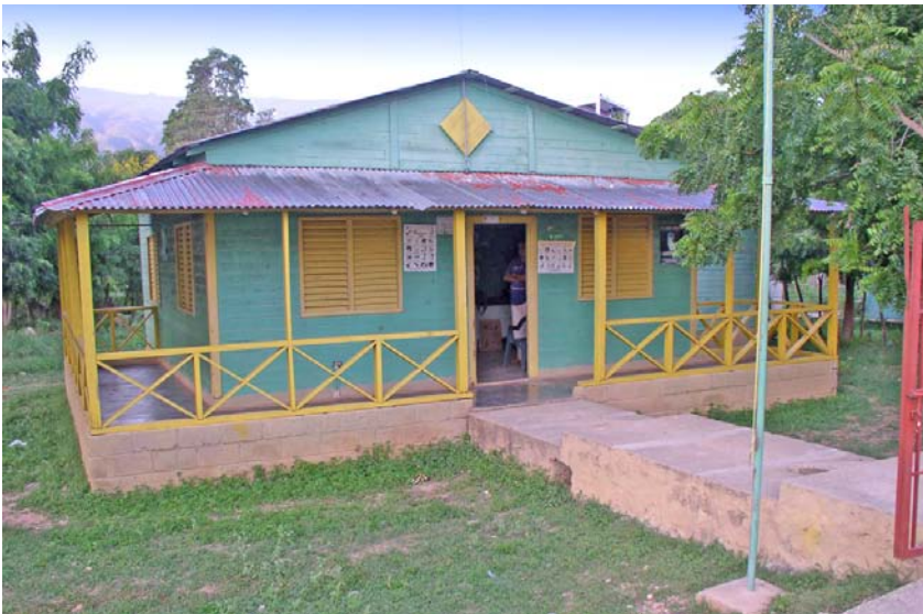
Oficina administrativa del PNSB en Puerto Escondido (vertiente N). Desde su ubicación es posible observar todos los vehículos que entran al Parque Nacional por esta ruta (foto: J. Martínez, 7/10/04)
