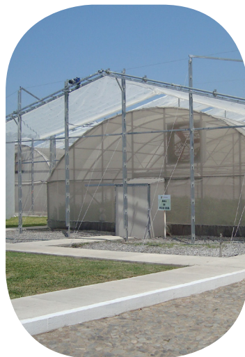
Figura 7. Estructura tipo invernadero.
