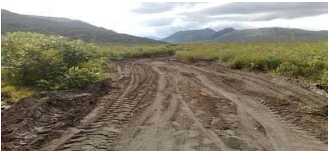
Figura 21: Construção de estrada com supressão de vegetação.
