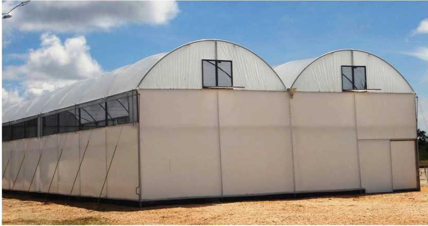
Figura 13. Casa de vegetação para produção de mudas clonais de Eucalyptus com pé direito de 4 m, cobertas com filme agrícola difusor e presença de janelas frontais e laterais e tela de alumínio termorrefletores retrátil (50%)
