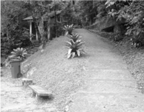
Figura 17: Acesso ao nível mais alto - rampa em concreto.
