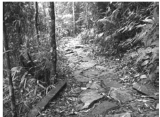
Figura 27: Pedras irregulares assentadas no piso.
