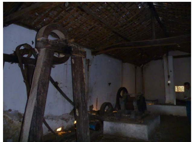
Foto 12. Estrutura de moagem
