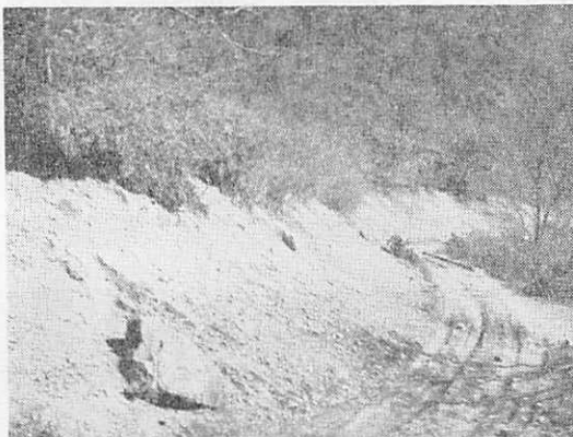
写真 1. 切り取り面が被ふくされないと、霜柱や凍結で土砂の移動がたえまない。 (岩手県盛岡市有志田林道)
