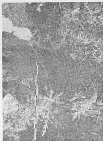
写真 10. イヌコリヤナギの埋幹 (施工後6カ月) 頑丈な根系を各筋工間の露出面に発達させ、 斜面下部の深土砂をおさえている。
