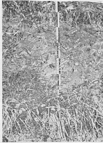
写真 12. 草本類の実播筋工, カワラケツメイとオーチャードグラスの成長はおお盛である。
