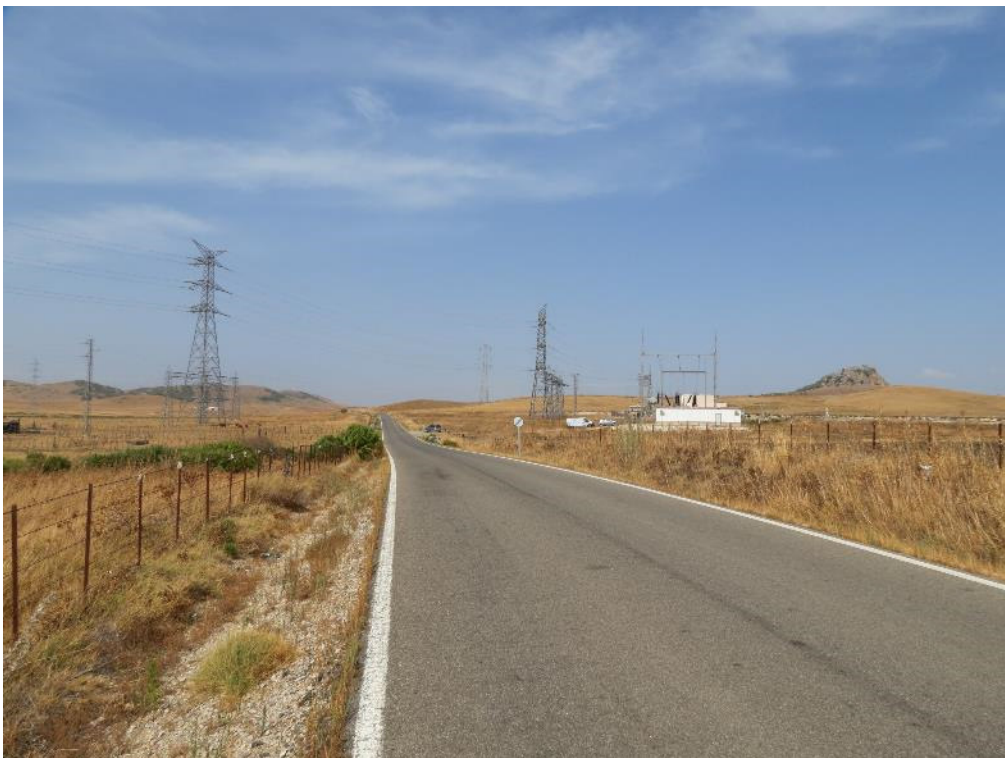
Vista de la carretera CA-5032 y la subestación Gazules (a la derecha).
