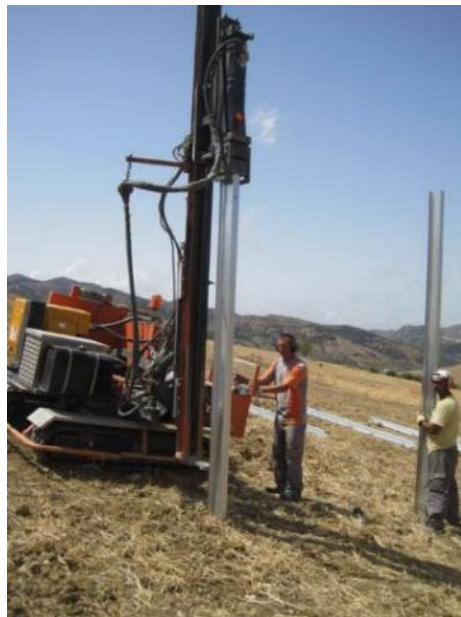
Montaje de estructura soporte
