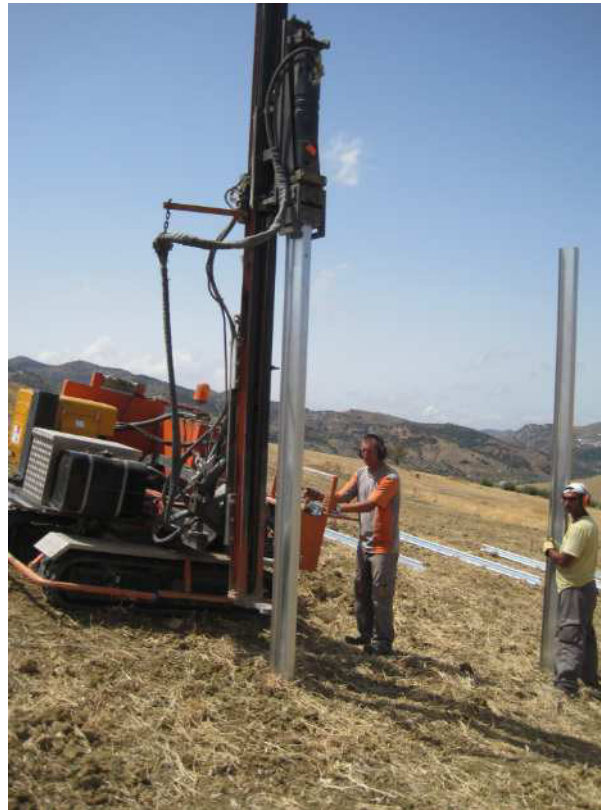
Ejemplo de hincado de estructura.
