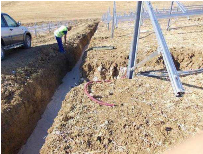
Ejemplo de zanjas para cableado AC
