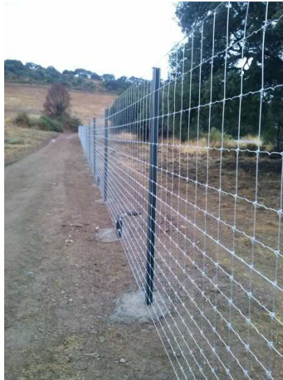
Ejemplo de valla de seguridad.
