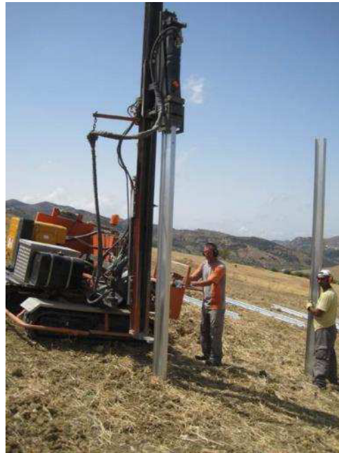
Montaje de estructura soporte
