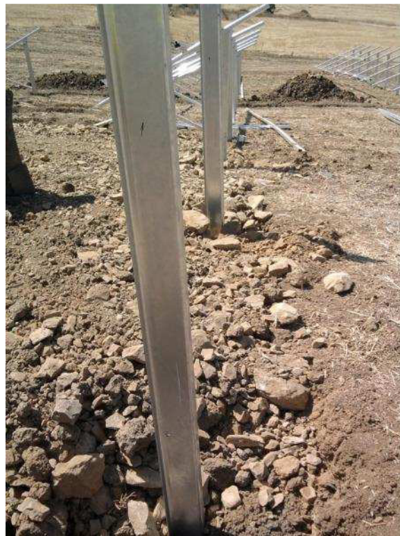
Ejemplo de hincado de estructura.
