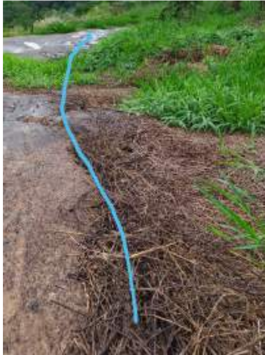
Figura 11 – Acúmulo suspeito de material vegetal em área próxima ao plantio (linha em azul indica o caminho que a água percorre após a chuva).
