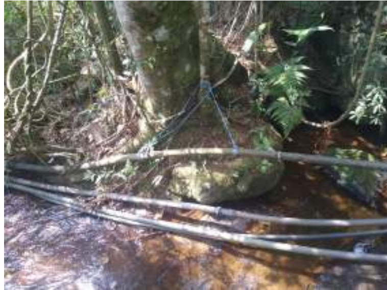
Figura 2 – Canos que levam água às propriedades próximas ao Parque amarrados em árvores nativas.
