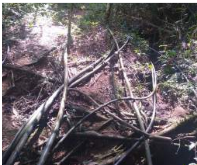
Figura 6 – Canos sobre o solo em direção às propriedades particulares externas à Unidade de Conservação.
