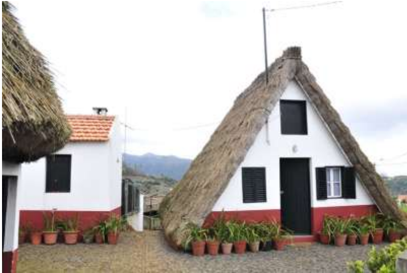
Figura 38. Casas de colmo na freguesia de Santana
