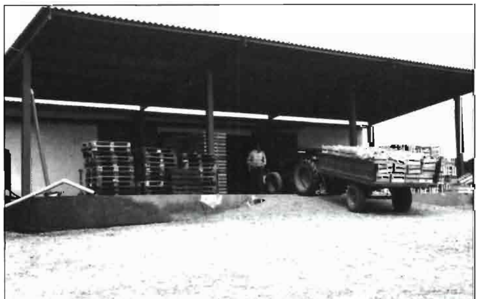
Almacén central con la recepción de las hortalizas procedentes del campo para su acondicionamiento.
