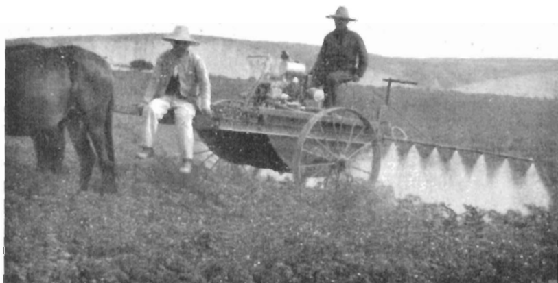
Pulverización de garbanzales con caldos cúpricos para prevenir la enfermedad conocida con el nombre de «rabia» (Córdoba).
