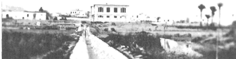
Edificio en construcción para la Estación Fitopatológica de Almería y campos de experiencias en los que se ha establecido el regadío.
