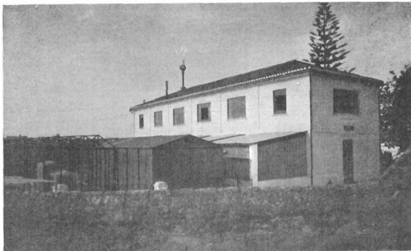
Pabellón destinado a insectarios de la Estación de Fitopatología Agrícola de Valencia.
