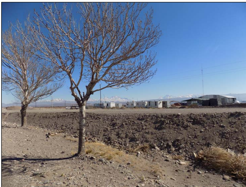
Fotografía N° 7 Campamento de construcción de la nueva RN 40
