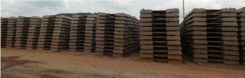
Figure 6 : Stockage des traverses en béton pour être postérieurement transportées tout le long de la voie ferrée pour remplacer les traverses en bois
