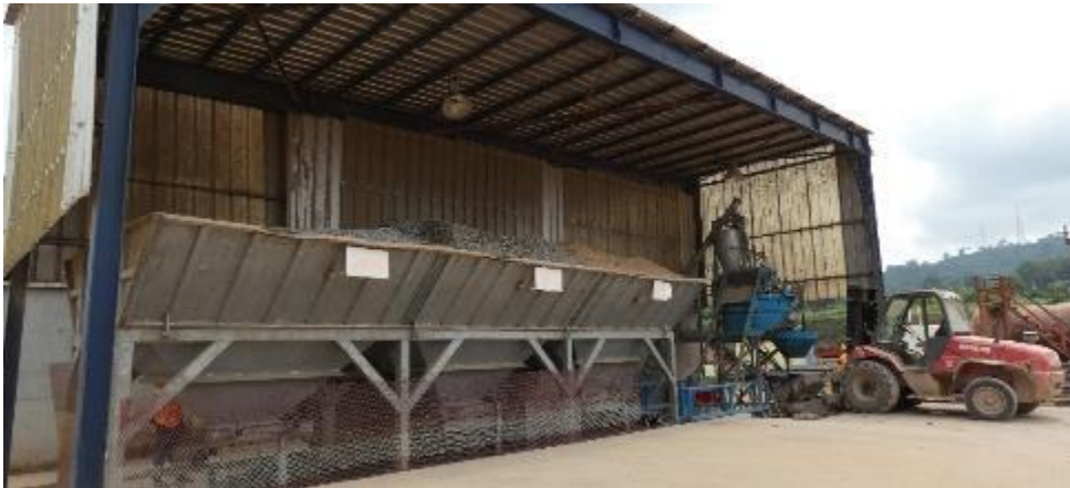
Figure 4 : Installation permettant le mélange du sable fin, sable gros grain et ciment permettant d'obtenir la consistance souhaitée de béton. Le processus est automatisé.
