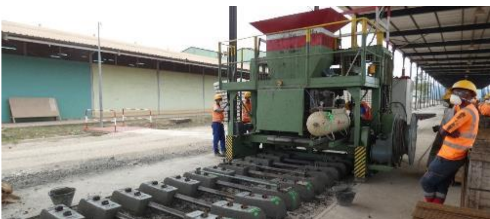
Figure 5 : Création des traverses en béton
