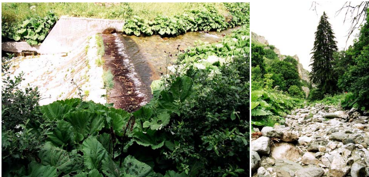
Целосен зафат на водата во горниот тек на Аџина Река. Речното корито на Аџина Река, после зафатот на вода.
