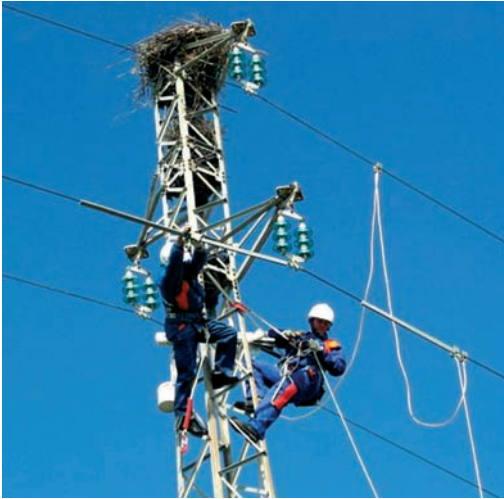
Figura 2: Intervento di messa in sicurezza del nido (foto L. Martelli - ENEL).
