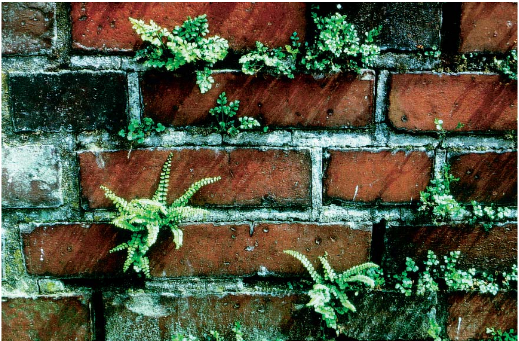
Abb.1 Mauertypische Vegetation an einer Backsteinmauer in Münster Mauerraute ( Asplenium ruta-muraria , oben und rechts) Schwarzstielliger Strichfarn ( Asplenium trichomanes , links und unten Mitte)
