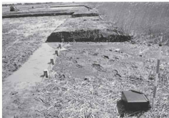
図3. 移植地①の越流堰。幅50 cm、長さ100 cmの鋼板を5枚並べ、高さをY.P.+1.35 mに調整した。越流堰の内側（左側）には敷き詰めたヨシのブロックが見える。
