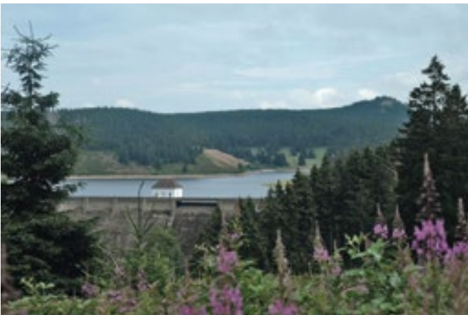
Abb.: 3.22: Die Staumauer der Eckertalsperre wurde in den 30er Jahren des vorigen Jahrhunderts errichtet und hat auf ihrer Krone einen reichen Flechtenbewuchs. Im Hintergrund der Scharfenstein. Foto: W. Störmer.
